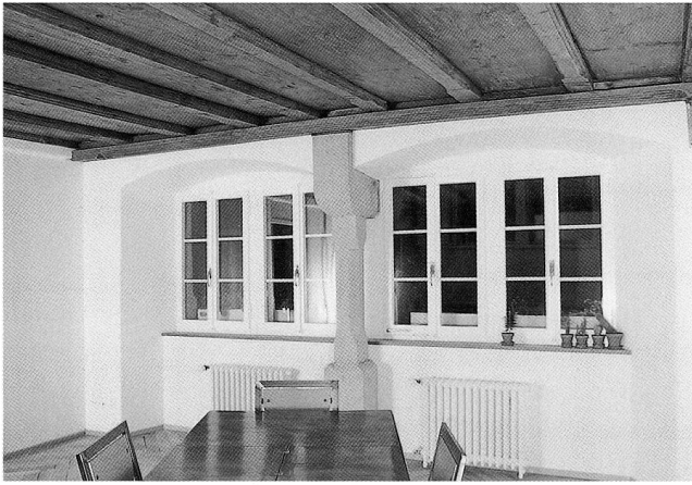
Abb. 40 Zug, Unteraltstadt 24. Fenstersäule und gotische Balkendecke im ersten Obergeschoss, nach der Restaurierung.
