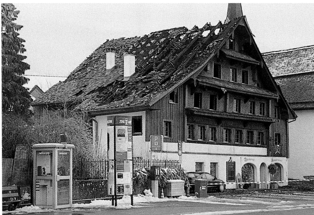
Abb. 22 Zug, Oberwil, Artherstrasse 111/113. Blick auf die Brandruine, Januar 2000.
