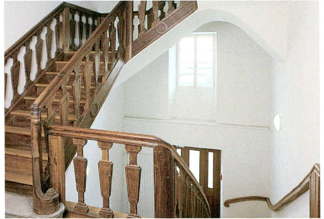
Abb. 25 Zug, Chamerstrasse 33. Ehemaliges Bürgerasyl. Treppenhaus, nach der Restaurierung.
