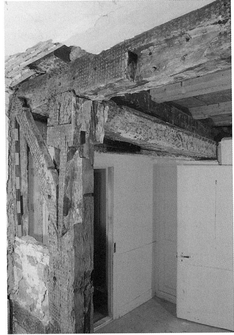
Abb. 34 Zug, Kolinplatz 21. Erstes Obergeschoss. Jüngerer Fachwerk (links) und ein ins zweite Obergeschoss weiterziehender Ständer des Kernbaus.
