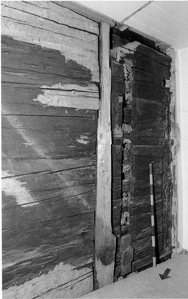
Abb. 18 Oberägeri, Küfergasse 2. Kombination aus Blockbau (rechts) und «Ständerbau» (links).
