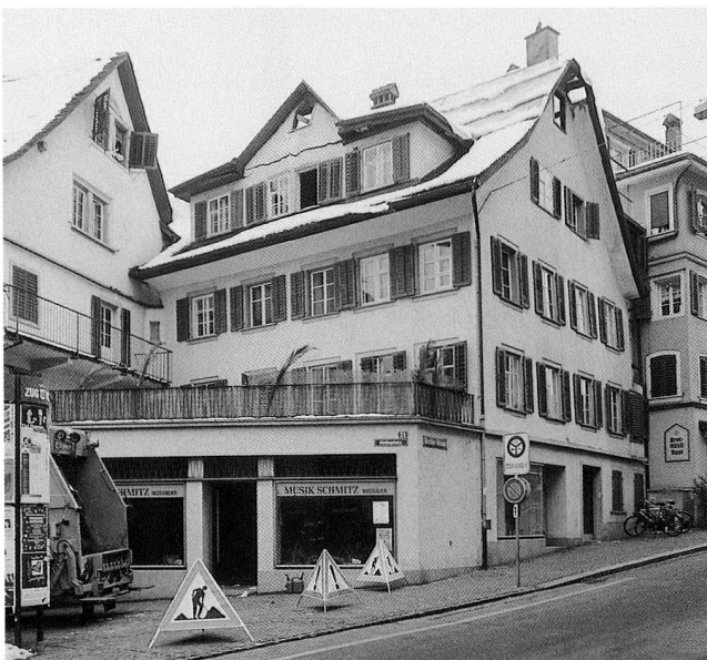
Abb. 32 Zug, Kolinplatz 21. Ansicht von Westen. Nach dem Brand, Ende 1999.
