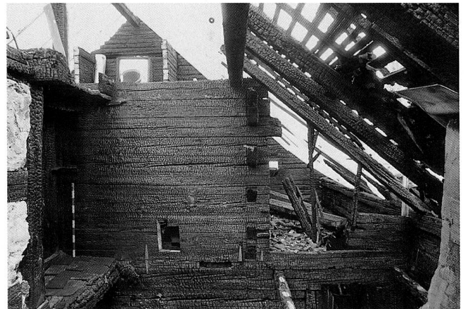
Abb. 23 Zug, Oberwil, Artherstrasse 111/113. Dachgeschoss mit Resten des Kernbaues in Blockbauweise. Blick Richtung Südwesten.
