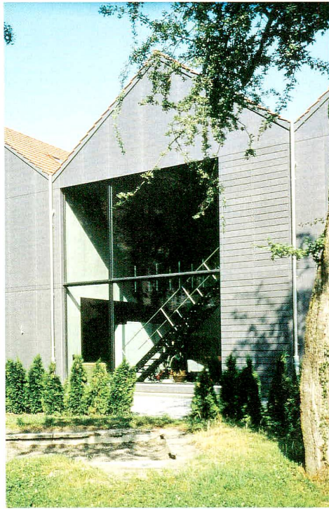
Abb. 9 Cham, Hagendorn. Loft im ehemaligen Spinnereigebäude, 2000. Aussenansicht und Innenraum.
