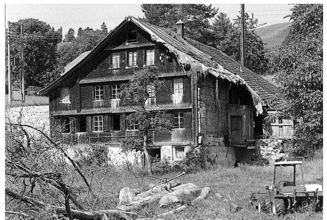
Abb. 14 Menzingen, Halthof. Blick Richtung Westen, Zustand Anfang 2000.
