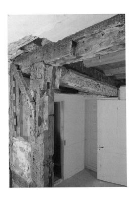
Abb. 35 Zug, Kolinplatz 21. Zweites Obergeschoss. Reste des Kernbaues in Bohlen-Ständer-Bauweise, links der Bildmitte der Mittelständer (Aussenseite) in der nördlichen Fassade. Blick Richtung Südosten.
