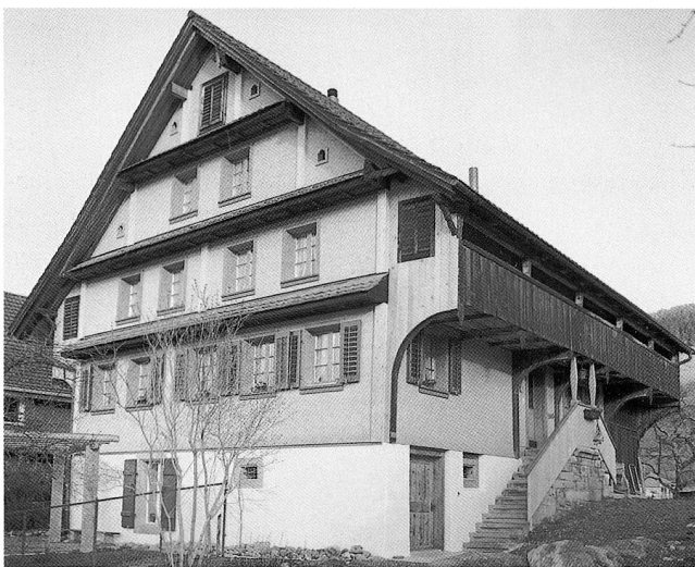
Abb. 17 Oberägeri, Eggstrasse 31. Wohnhaus nach der Restaurierung.
