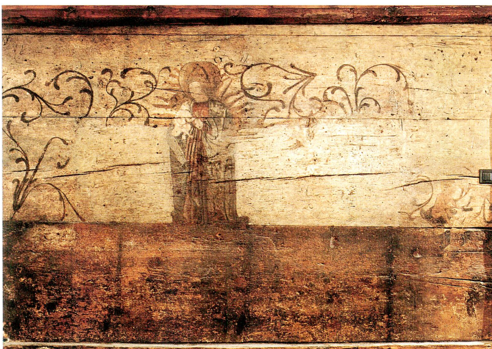
Abb. 9 Zug, Dorfstrasse 2. Erdgeschoss, Nordostraum. Südwand mit Bohlenmalerei. Die unbemalte Fläche im unteren Teil der Bohlenwand und die dunklen senkrechten Verfärbungen deuten darauf hin, dass zur Malerei ein Brusttäufer gehört hat.
