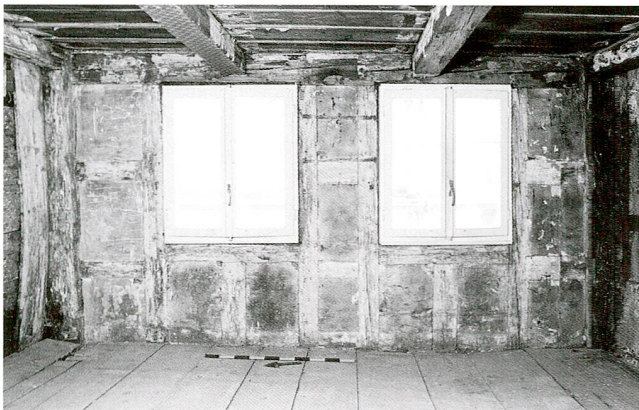
Abb. 11 Zug, Dorfstrasse 2. Erstes Obergeschoss, Raum 13, Ostwand. Riegelkonstruktion mit gemauerten Ausfachungen. In den Raumecken sind noch Fassadenständer des Bohlenständerbaus zu erkennen.
