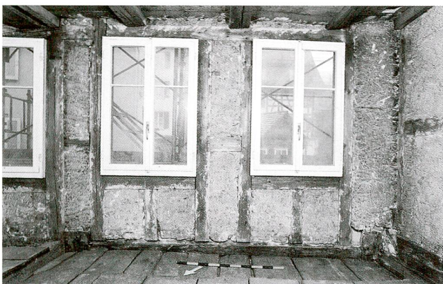
Abb. 12 Zug, Dorfstrasse 2. Erstes Obergeschoss, Raum 14, Ostwand. Riegelkonstruktion mit gemauerten Ausfachungen.
