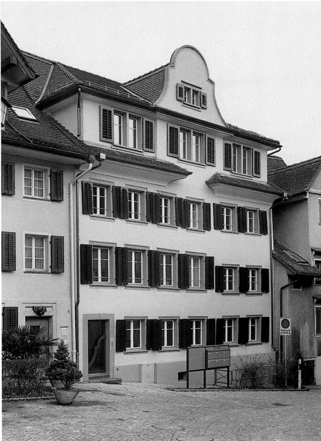
Abb. 1 Zug, Dorfstrasse 2. Blick auf die Ostfassade, welche bei der Restaurierung von 1999 lediglich einen neuen Verputz und einen frischen Farbanstrich erhielt. Die Anordnung und Grösse der Fenster blieb unverändert.
