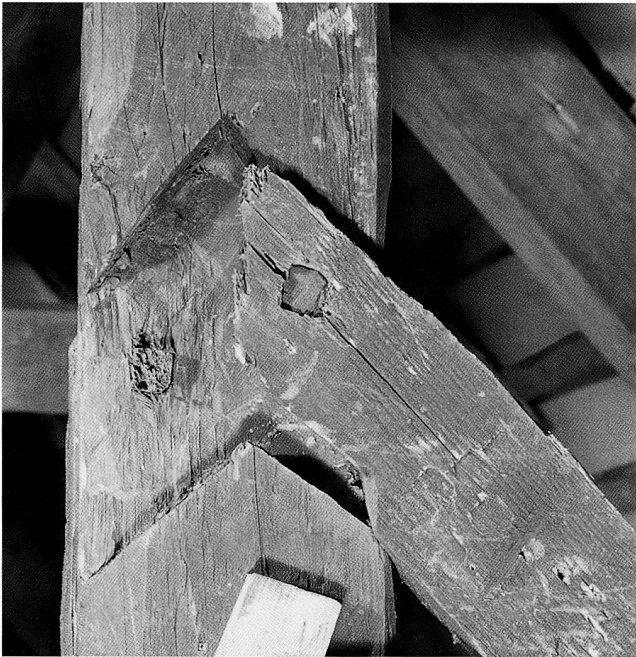
Abb. 8 Zug, Dorfstrasse 2. Dachstock. Beispiel einer Strebe, die nicht genau in den Ausschnitt am Firstständer passt.
