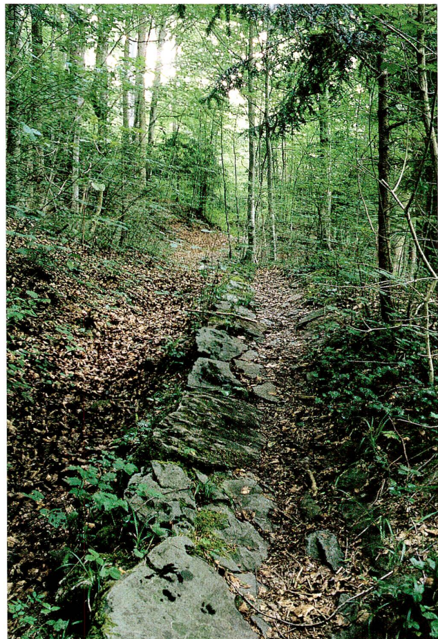
Abb. 5 Die in einem kurzen Abschnitt noch erhaltene Oberflächenpflasterung des Aufstiegs von der Lorzentobelbrücke nach Schönbrunn. Diese wurde im Zusammenhang mit der 1759 gebauten Brücke angelegt.
