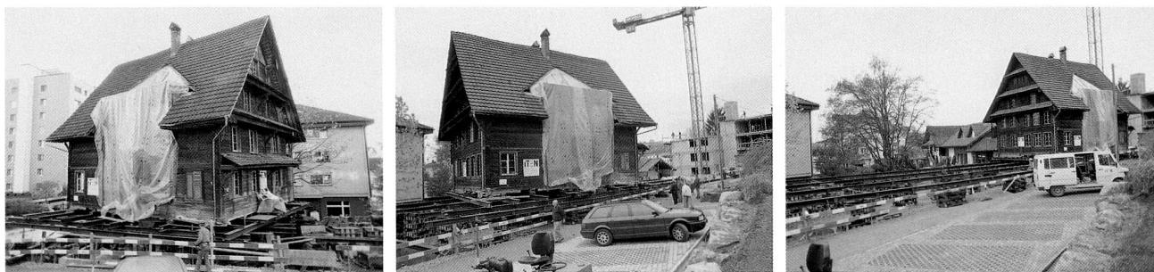
Abb. 15 Steinhausen, Bannstrasse 4. Verschiebung des Hauses.
