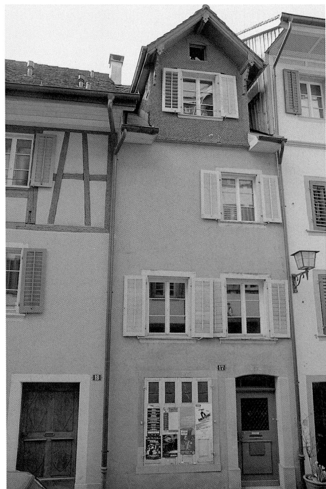
Abb. 26 Zug, Oberaltstadt 17. Südostfassade bei Beginn der Umbauten.
