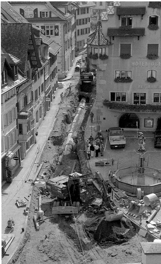
Abb. 23 Zug, Ägeristrasse. Während der Sanierung 1999, Blick Richtung Osten.
