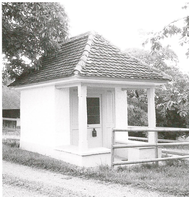
Abb. 7 Risch, Kapelle Berchtwil. Nach der Restaurierung, 2000.
