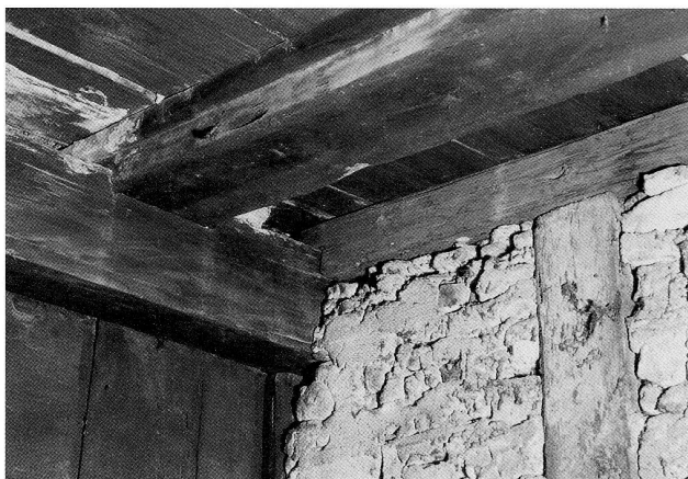
Abb. 27 Zug, Oberaltstadt 17. Zweites Obergeschoss, Northwest-Ecke. Links die durchlaufende alte Bausubstanz, rechts die später eingezogene Fachwerkwand.
