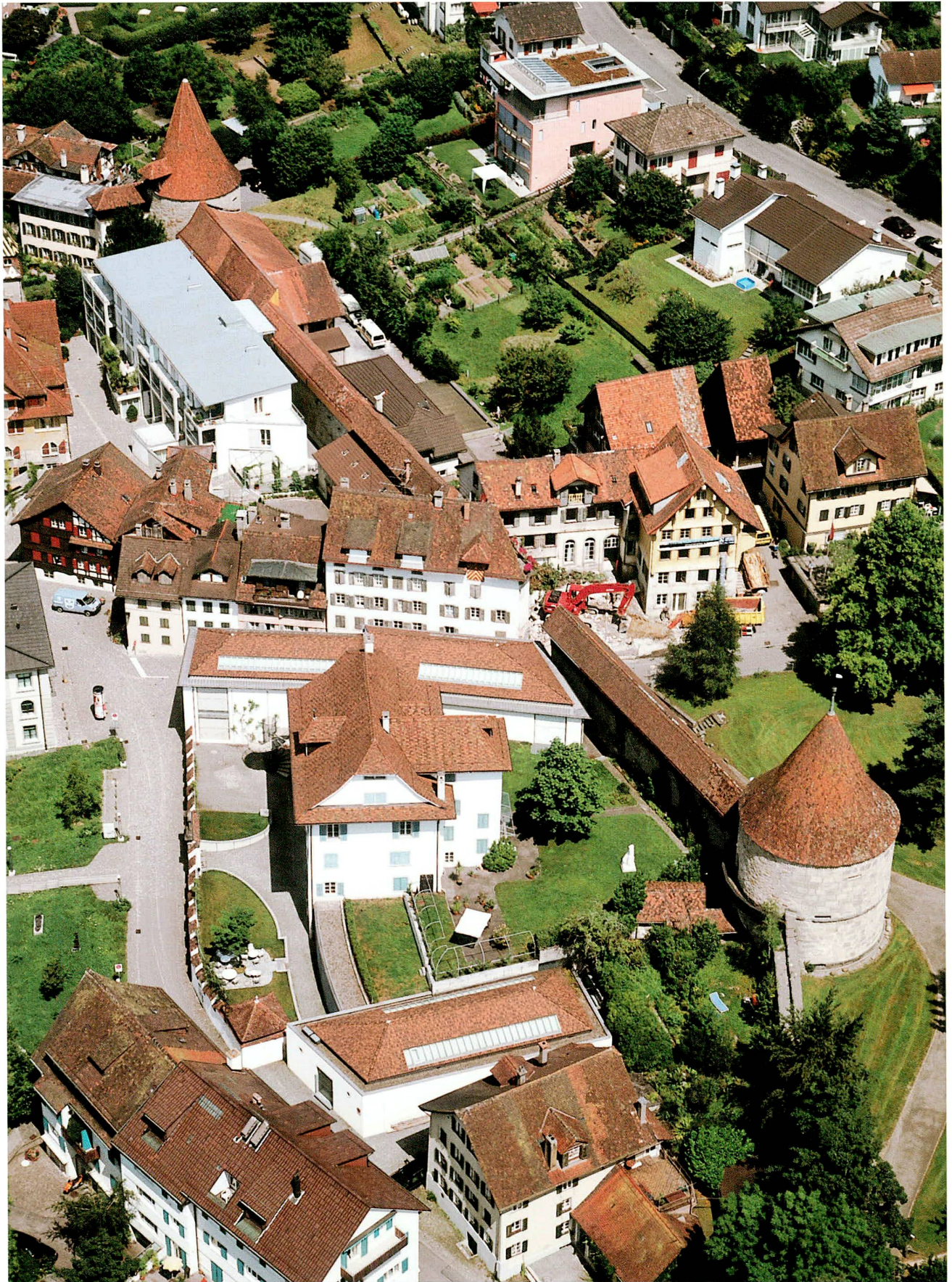
Abb. 24 Äussere Stadtmauer zwischen Knopfliturm (links oben) und Huwilerturm (rechts unten), Zustand 1999. Gut erkennbar ist die z. T. rekonstruierte Wehrgangbedachung. Rechts der Bildmitte befindet sich ausserhalb der Stadtmauer die Liegenschaft Bohlstrasse 7 mit dem an die Stadtmauer heranreichenden Nebengebäude (heute durch einen Neubau ersetzt).
