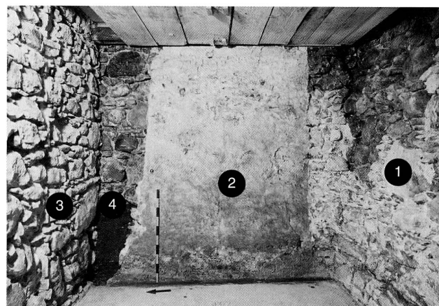
Abb. 5 Seehof, Erdgeschoss, Südostrum, Blick Richtung Osten, Befunde teilweise freigelegt. 1 Stadtmauer. 2 Westwand der Liebfrauenkapelle (Aussenseite). 3 Interne Trennwand des Seehofes. 4 Unterkante der Kapellenwand (ca. 0,8 m über dem modernen Boden). Die Fundamentunterkante der Stadtmauer im Bereich zwischen modernem Boden und Fundamentunterkante der Kapellen-Westwand konnte nicht genau bestimmt werden.
