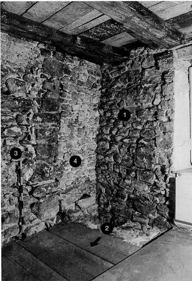
Abb. 6 Seehof, zweites Obergeschoss, Südostraum, Blick Richtung Südosten. 1 Stadtmauer. 2 Ursprünglicher Wehrgang. 3 Westwand der Liebfrauenkapelle (Aussenseite). 4 Zustufung im Bereich des ursprünglichen Umganges an der Mauerinnenseite.
