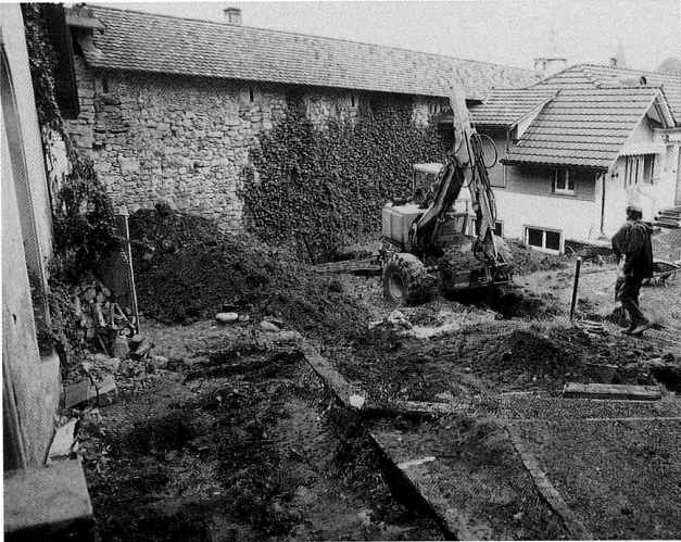
Abb. 22 Liegenschaft Bohlstrasse 7, Blick Richtung Nordwesten. Aussenseite der Stadtmauer. Sondierarbeiten mit dem Bagger.
