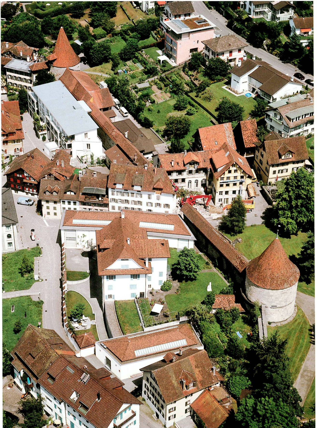
Abb. 24 Äussere Stadtmauer zwischen Knopflerturm (links oben) und Huwilerturm (rechts unten), Zustand 1999. Gut erkennbar ist die z. T. rekonstruierte Wehrgangbedachung. Rechts der Bildmitte befindet sich ausserhalb der Stadtmauer die Liegenschaft Bohlstrasse 7 mit dem an die Stadtmauer heranreichenden Nebengebäude (heute durch einen Neubau ersetzt).
