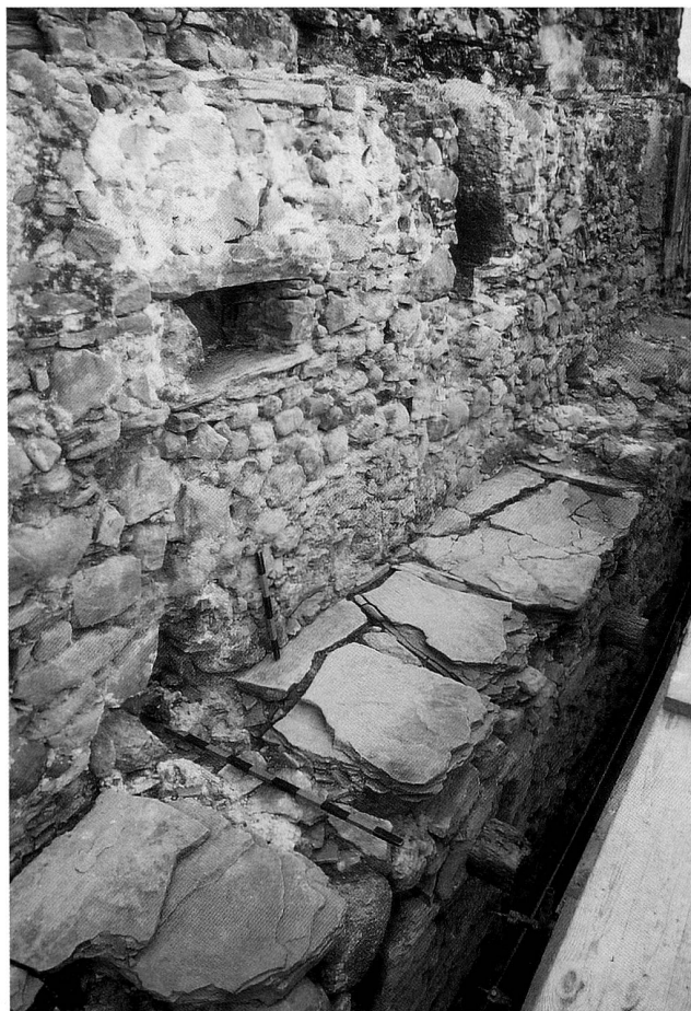
Abb. 17 Quartier Dorf. Innenseite der Stadtmauer auf der Höhe des Wehrganges, Blick Richtung Süden. Sandsteinplatten des ursprünglichen Gehhorizontes und waagrechte originale Schiesscharte. Im Bereich der liegenden Messlatte (Einteilung in Dezimeter) befindet sich der Ausbruch für einen Unterzug des jüngeren Holzaufbaus. Die Balkenköpfe unterhalb des Wehrganges stammen von neuzeitlichen Anbauten.
