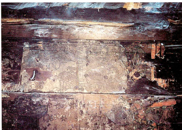
Abb. 37 Zug, Friedhofgärtnerei St. Michael, Nordwestraum im Erdgeschoss. Reste von Holzschnitten, vor der Abnahme und Restaurierung, 1997.
