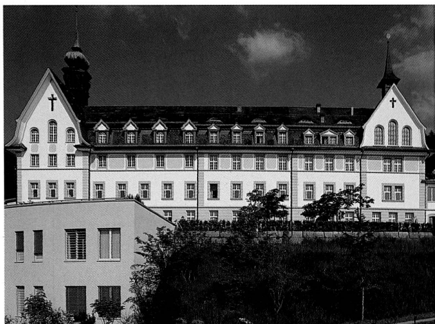
Abb. 38 Zug, Oberwil, Franziskusheim, nach der Restaurierung, 1999.
