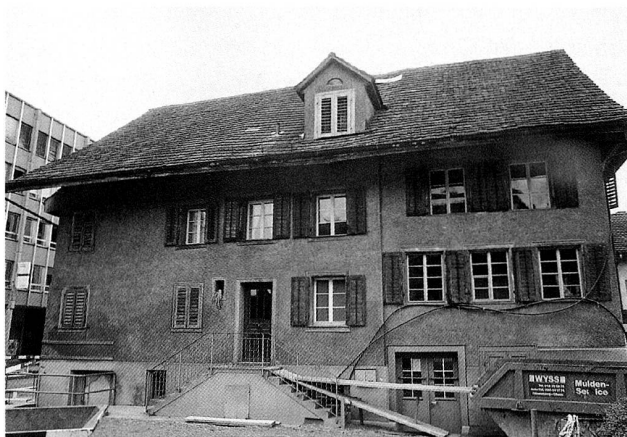
Abb. 2 Baar, Dorfstrasse 8. Aussenfassade mit der Trennung in Blockbau (links) und Ständerbauteil (rechts). Blick Richtung Südwesten. Zustand bei Untersuchungsbeginn.
