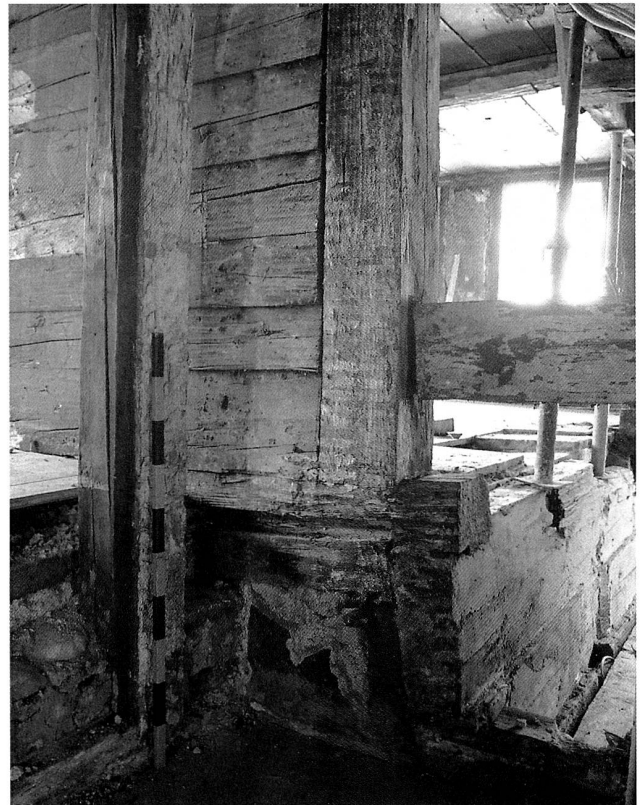
Abb. 4 Baar, Dorfstrasse 8. Der Mittelständer des Ständerbaus ist auf Teilen des Blockbaues platziert. Blick Richtung Nordosten.
