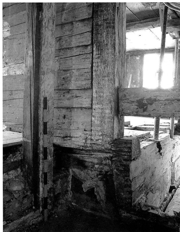
Abb. 4 Baar, Dorfstrasse 8. Der Mittelständer des Ständerbaus ist auf Teilen des Blockbaues platziert. Blick Richtung Nordosten.
