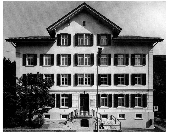
Abb. 25 Zug, Ägeristrasse 56. Die ehemalige Zigarrenfabrik von Norden, nach der Restaurierung, 1998.
