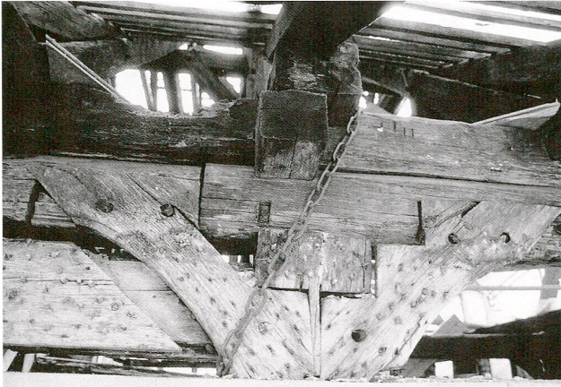
Abb. 15 Zug, Stolzengraben. Nordostständer der Stube im Südwesten. Profilierte Kopfstreben des Ständerbaues aus den Jahren um 1442 am Übergang zum Dach, darüber die Dachkonstruktion von 1546.
