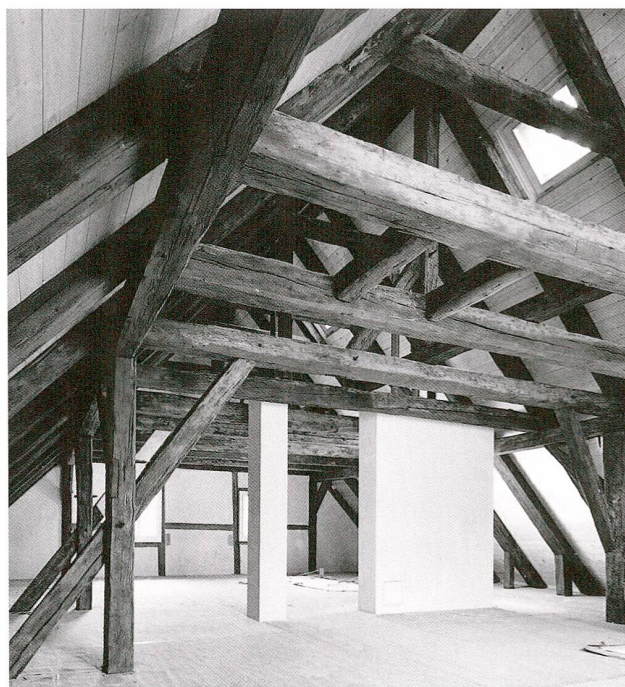
Abb. 26 Zug, Stolzengraben. Dachraum, nach der Restaurierung.
