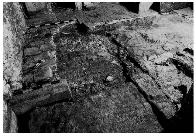
Abb. 6 Zug, Stolzengraben. Erdgeschoss, Mittelteil, Blick Richtung Südosten. Die südliche der beiden Zwischenschwellen des Ständerbaus (im Bild von unten rechts nach oben Mitte verlaufend) ist teilweise als Negativ in der Kalotte des Gewölbekellers erhalten (Bildmitte). Das Gewölbe muss also gegen den bereits vorhandenen Ständerbau gesetzt worden sein.
