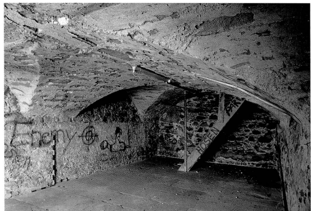
Abb. 2 Zug, Stolzengraben. Südlicher Kellerraum, Blick Richtung Osten.
