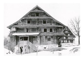
Abb. 8 Zweieren, Haus B. Nördliche Giebelseite. In den beiden Dachgeschossen erkennt man Elemente in Bohlen-Ständer-Technik. Im Hintergrund rechts ist Haus A zu sehen. Zustand 1977.
