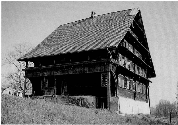
Abb. 2 Zweieren, Haus A. Südliche Giebelseite und westliche Traufseite. Zustand 1997, während der Renovierung.
