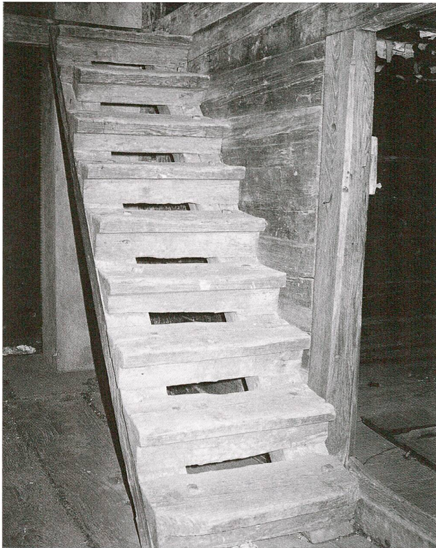
Abb. 12 Zweieren, Haus B. Blocktreppe zwischen den beiden Dachgeschossen. Zustand 1987.
