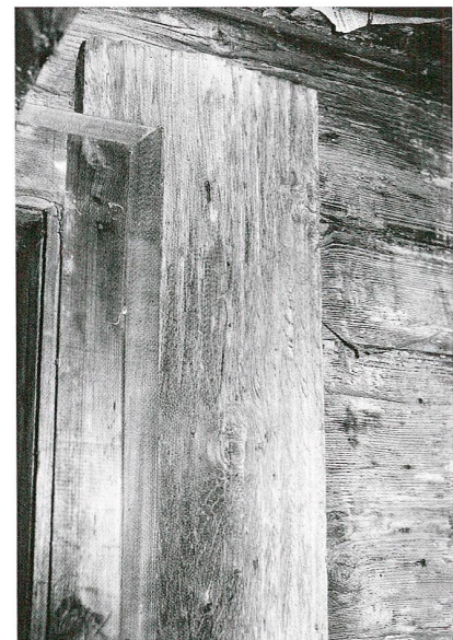
Abb. 11 Zweieren, Haus B. Östliche Traufseite. Kannelierter Pfosten der originalen Eingangstür. Zustand 1987.
