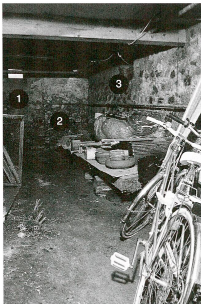
Abb. 5 Baar, Sigristenhaus. Untergeschoss, südlicher Kellerraum. Blick nach Osten. 1 Ostwand. 2 Zumauerung der ehemaligen Türöffnung. 3 Südwand.
