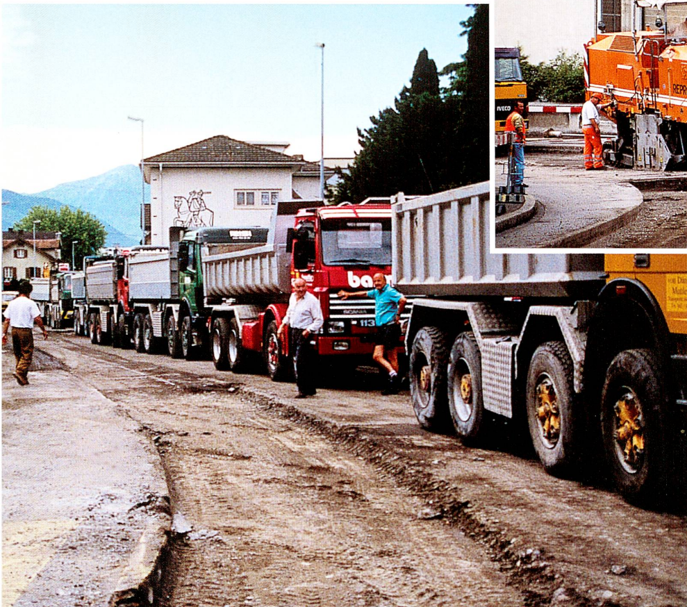
Abb. 1 Startschuss zum Baarer «Bauspektakel». Der Deckbelag wird entfernt und im 4-Minuten- Takt mit Lastwagen abgeführt.
