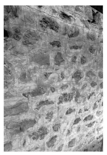
Abb. 8 Romanisches Mauerwerk an der Kirchenostwand mit zugehörigem Pietra-rasa-Verputz mit Fugenstrich. Übersicht.
