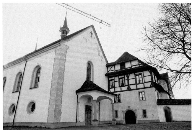
Abb. 11 Kirchenwestseite mit Vorzeichen. Zustand vor Beginn der Renovierung 1997.
