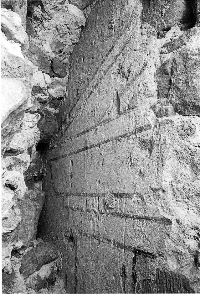
Abb. 21 Nordostecke im Obergeschoss des Innenhofes mit Architektur-Scheintmalerei. Rechts ist die Innenwand des Osttraktes, links die Südseite der Klosterkirche zu sehen.
