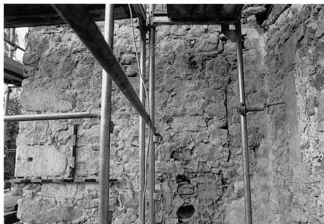
Abb. 7 Aussenseite der Nordwand des Kapitelsaales im Osttrakt (zur Lage vgl. Abb. 2). Die romanische Bausubstanz reicht vom Turmunterbau (auf dem Foto rechts) bis in die Nordwand des Kapitelsaales (links). Deutlich ist in der rechten Bildmitte die vertikale Baufuge zu erkennen.
