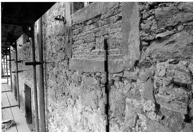
Abb. 22 Obergeschoss des Osttraktes, Aussenseite. Eine Tür führte hier zunächst in eine vor der Aussenfassade liegende Toilette. Diese ist als Holzerker o. ä. zu rekonstruieren, wie die mit Backsteinen zugemauerten Balkenlöcher (rechts) belegen. Nachträglich wurde diese Tür im unteren Teil zugemauert und als Fenster weiterbenutzt. Einteilung der Messlatte in 10 cm.
