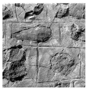
Abb. 9 Romanisches Mauerwerk an der Kirchenostwand mit zugehörigem Pietra-rasa-Verputz mit Fugenstrich. Detail.
