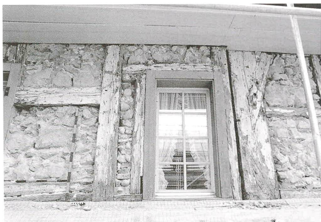
Abb. 18 Detail im Obergeschoss des Westtraktes (vgl. Abb. 17). Rechts des Fensters ist ein Ständer mit Kopfholtz zu sehen, links des Fensters liegt ein Teil der Fachwerk-Konstruktion frei. Einteilung der Messlatten in 10 cm.
