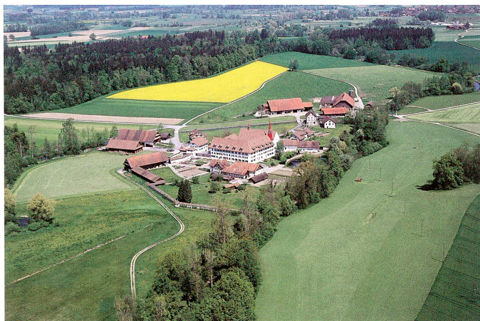
Abb. 1 Flugaufnahme des Klosterareales von Südosten, 1998. Die Anlage liegt zwischen zwei Armen der Lorze, die durch die Baumreihen in der Bildmitte und am linken Bildrand markiert sind.
