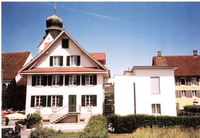
Abb. 9 Baar, Restaurant Freihof mit beige gestelltem Neubau nach der Restaurierung, 1997.
