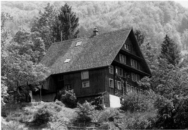
Abb. 25 Walchwil, Vorderbergstrasse 39, Dürrenburg. Ansicht von Nordwesten, Zustand 1978.
