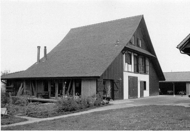
Abb. 13 Hünenberg, Trotte Strimatt. Nach der Restaurierung, 1997.
