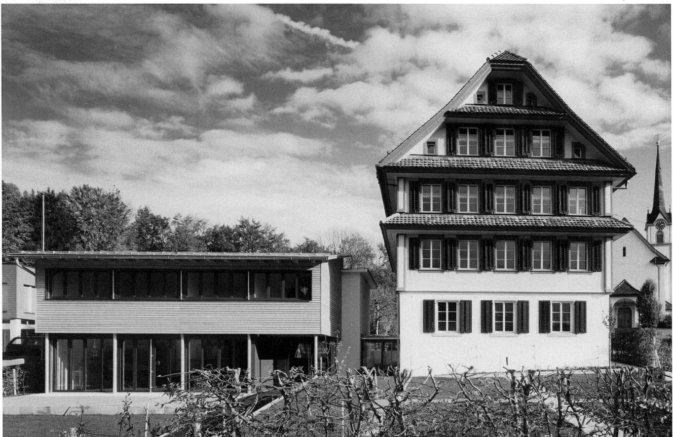
Abb. 2 Baar-Allenwinden, Pfarrhelferhaus. Blick auf das Gebäude und den beigeestellten Neubau nach der Restaurierung, 1997.
