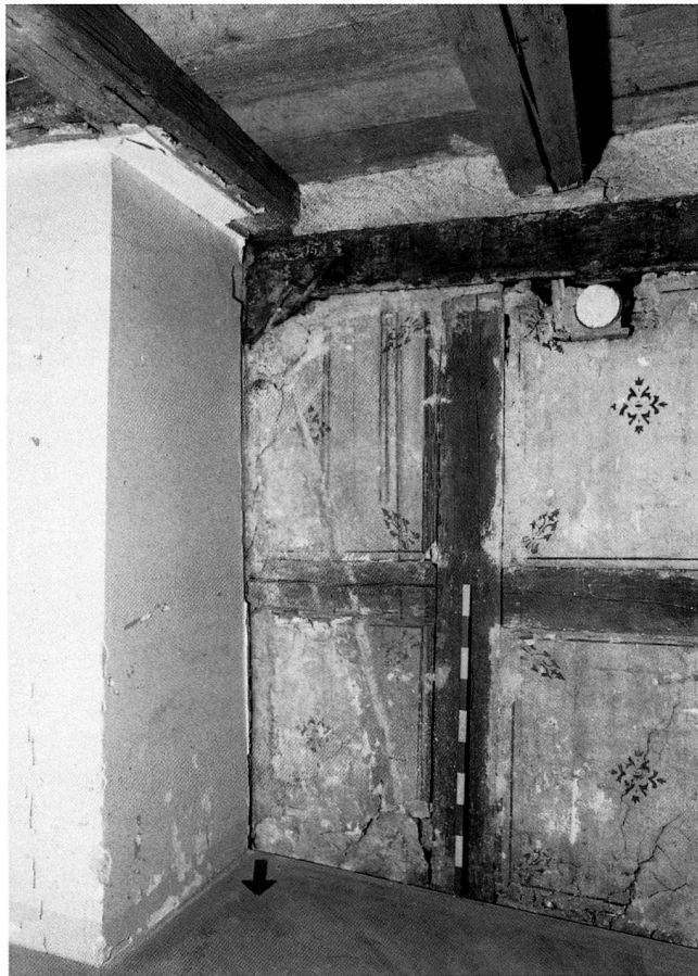
Abb. 26 Stadt Zug, Ägeristrasse 15. Zweites Obergeschoss, Nordraum des Hauptbaues. Schablonenmalerei. Links oben ist ein Kopfholtz zu sehen, das den Spannbalken mit dem (links verdeckten) Ständer verbindet.
