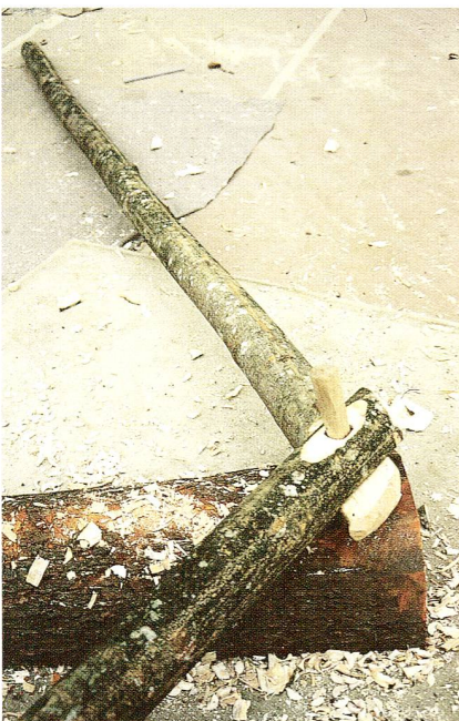
Abb. 16 Die Sparren wurden am First miteinander verdübelt und halten sich so gegenseitig.
