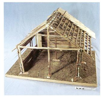
Abb. 12 Vor der Errichtung des Hauses in Originalgrösse wurde ein Modell im Massstab 1:10 hergestellt. Es zeigt noch verschiedene Merkmale, die bei der 1:1-Rekonstruktion anders gestaltet wurden. Wesentlichster Unterschied sind die Wandfüllungen. Sie bestehen beim Modell aus waagrechten, beim nachgebauten Haus aus senkrechten Rundhölzern.
