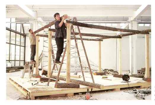
Abb. 13 Mit dem Auflegen der Fusspfetten erhielt der Haus-Rahmen erstmals eine gewisse Stabilität.
