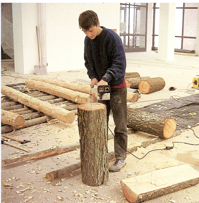
Abb. 10 Die Pfahlschuhe wurden mit der Kettensäge zurechtgesägt und anschließend von Hand überarbeitet.
