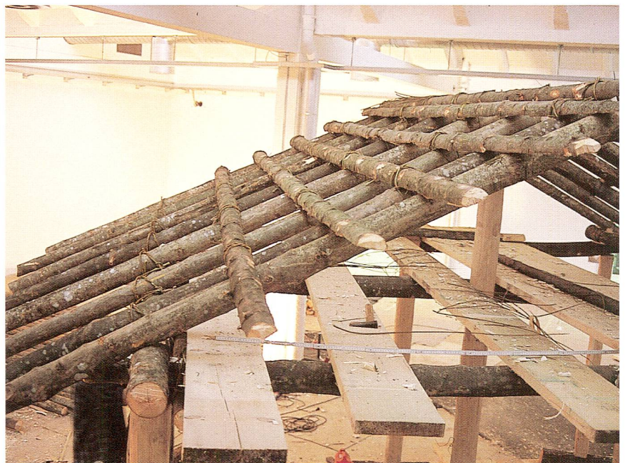
Abb. 17 Auf die Sparren wurden Dachlatten aus halbierten Tannenstämmchen aufgebunden.
