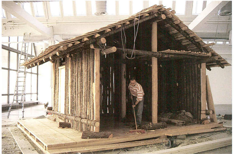
Abb. 24 Ansicht der rekonstruierten Haushälfte, noch ohne Boden- belag und vor dem Verstreichen der Wandfugen mit Lehm.
