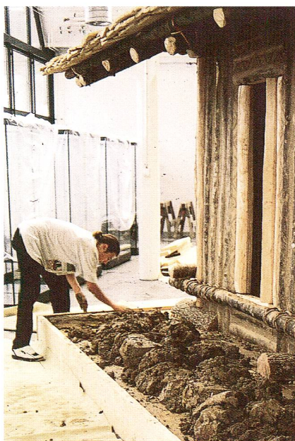
Abb. 21 Eine Mischung von Lehm, Sand und Seekreide bildet den Bodenbelag. Sie wurde von Hand verteilt und mit den Füßen festgestampft.
