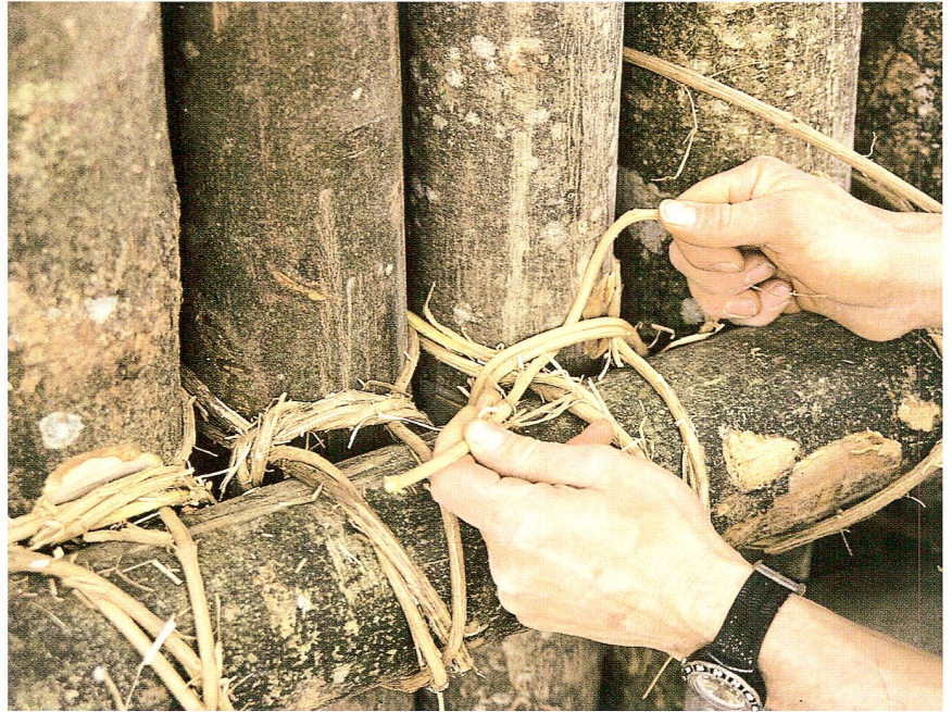
Abb. 15 Die einzelnen Rundhölzer der Wandfüllungen wurden oben und unten an ein waagrechtes Rundholz angebunden. Als Bindematerial diente Clematis.
