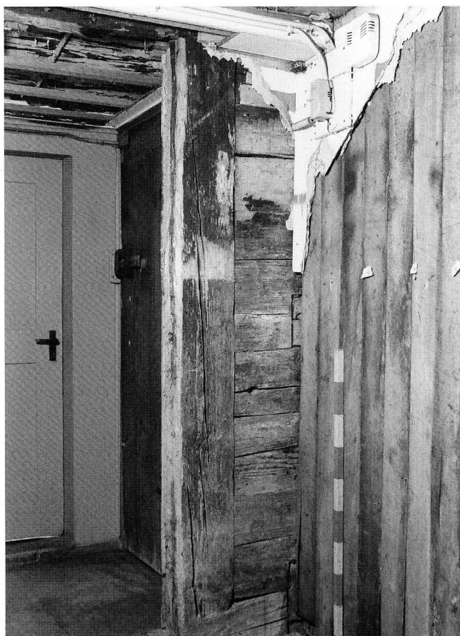
Abb. 14 Hünenberg, Burgstrasse 14, Burghus. Gang im Erdgeschoss, Blick Richtung Westen, Zustand 1994 nach Freilegungsarbeiten. Rechts sind Reste einer Blockwand (1450/60 dendrodatiert) sowie der Pfosten einer zugehörigen Tür zu sehen.
