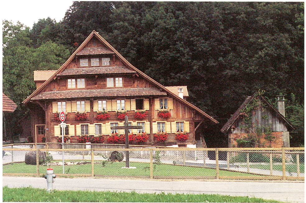
Abb. 15 Hünenberg, Burgstrasse 14, Burghus. Blick von Nordwesten nach der Restaurierung, 1995.
