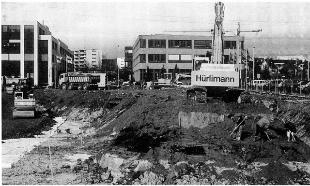
Abb. 28 Steinhausen, Cosmetochem. Ausgrabung/Notbergung 1995. Übersicht über die Baustelle.
