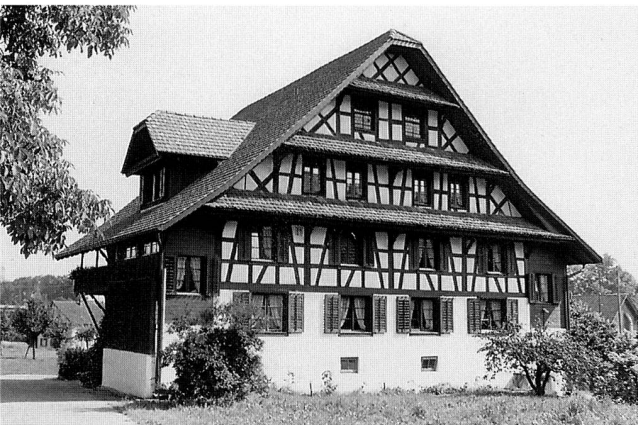
Abb. 7 Cham, Bauernhaus in Friesenham. Blick von Nordwesten nach der Restaurierung, 1995.
