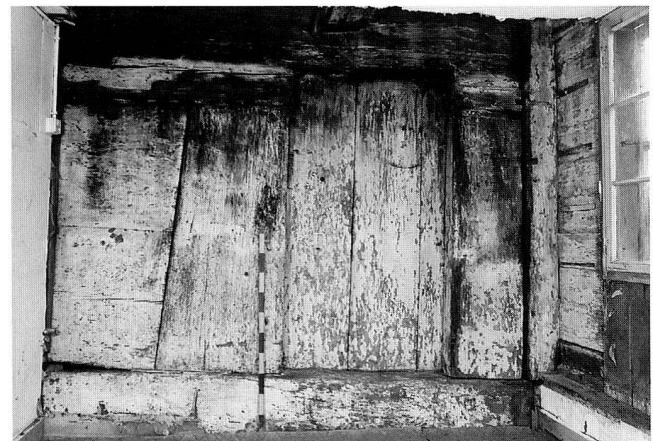
Abb. 13 Hünenberg, Burgstrasse, Haus Zum Weissen Wind. Erdgeschoss, östlicher Küchenteil, Blick Richtung Westen, während der Bauuntersuchung 1995.
