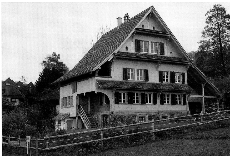
Abb. 36 Zug, Bauernhaus Badjöggel. Blick von Südwesten nach der Restaurierung, 1995.
