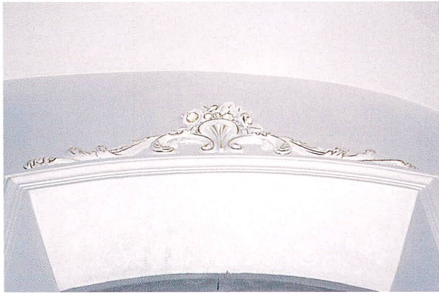
Abb. 32 Walchwil, Pfarrkirche St. Johannes der Täufer. Fragment der Stuckvergoldung von 1867 über der südwestlichen Seitenempore.
