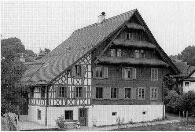
Abb. 3 Baar, Bauernhaus Unterbrüglen. Blick von Südosten nach der Restaurierung, 1995.
