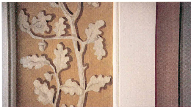
Abb. 33 Walchwil, Pfarrkirche St. Johannes der Täufer. Die Farbgebung am Gewölbe von 1904.
