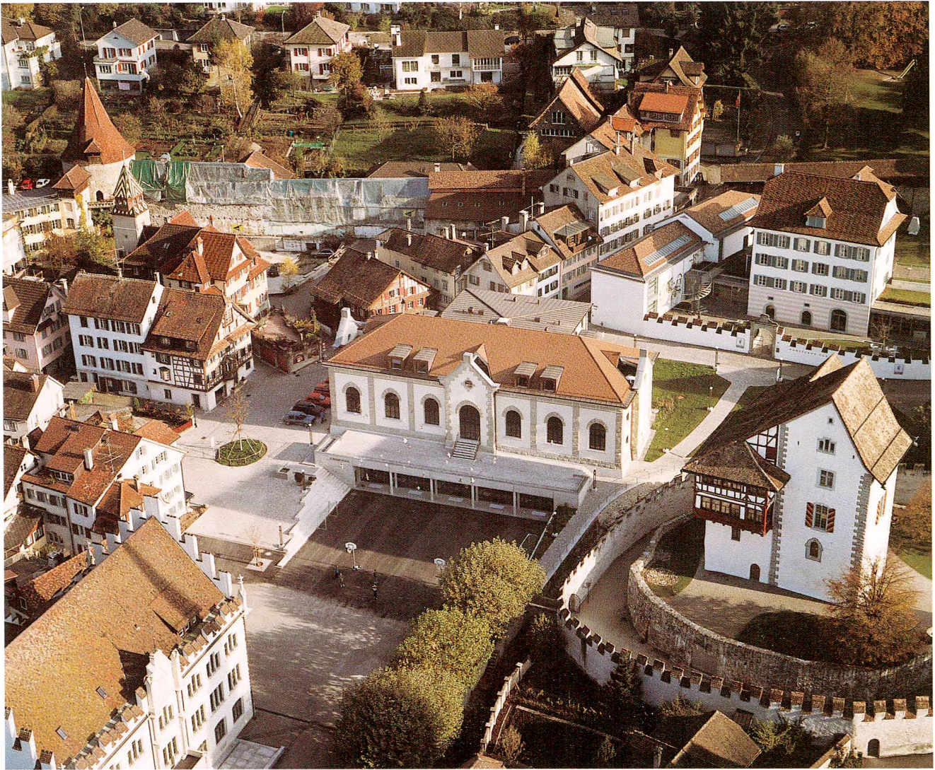
Abb. 38 Zug, Burgbachturnhalle. Blick von Südwesten nach der Erweiterung und Renovation, 1995.
