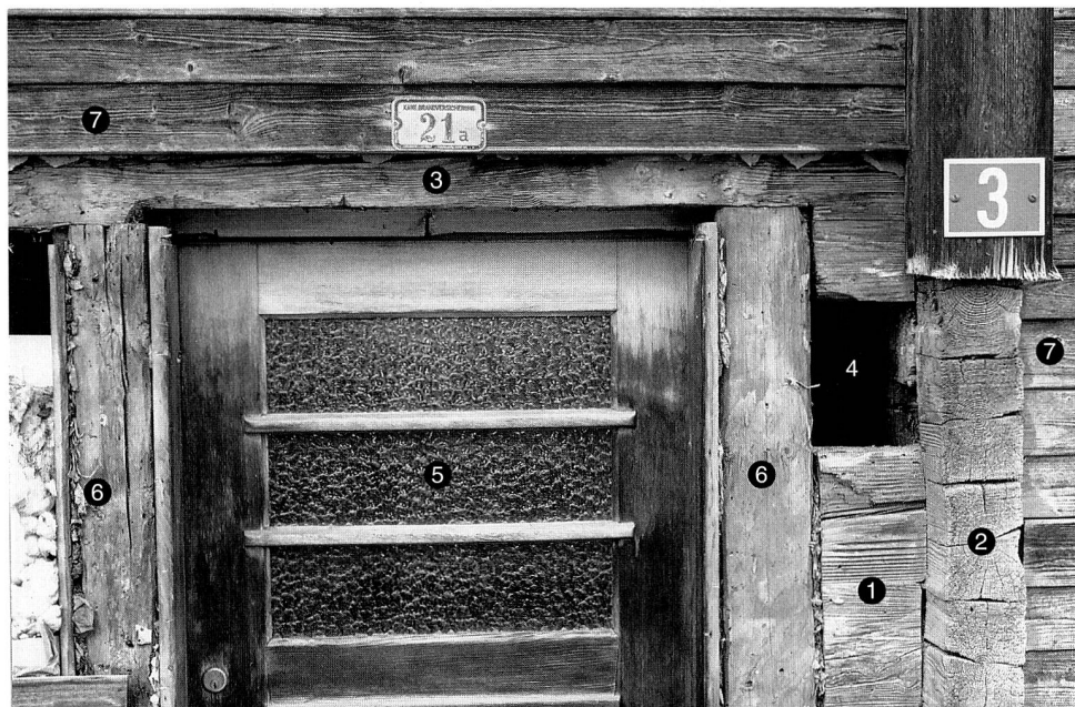
Abb. 4 Menzingen, «Kieferhaus». Teil der Ostfassade, Blick nach Westen. 1 Blockwand (Ostfassade). 2 Blockvorstoss der Korridornordwand. 3 Originaler Türsturz mit kielbogenartiger Fasse, daneben unverwitterte Stellen (Beleg für übergreifende Türpfosten). 4 Heiterloch. 5 Moderne Haustür. 6 Pfosten zur Haustür. 7 Moderne Bretterschaling.
