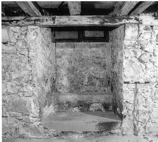
Abb. 7 Zug, St.-Oswalds-Gasse 16/18. Keller im Haus Nr. 16, Blick Richtung Norden an die Innenseite der Nordwand, während der Untersuchung 1993. In der rechten Bildhälfte ist die unterschiedliche Mauerstruktur von oberem und unterem Wandteil sichtbar. Im oberen Teil haben sich Konsolsteine erhalten. In der Wand war ein sekundär eingebrochener Eingang vorhanden, der nachträglich zu einem Fenster verkleinert worden ist. Länge der stehenden Messlatte 1 m.
