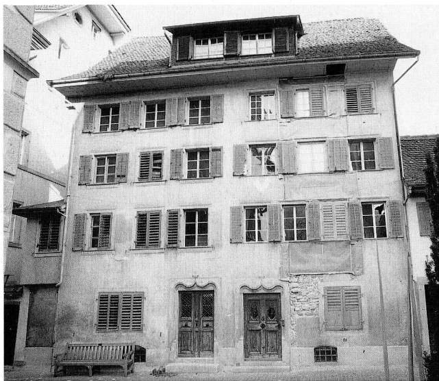
Abb. 1 Zug, St.-Oswalds-Gasse 16/18. Blick Richtung Westen auf die Ostfassade, Zustand 1993. Rechts ist der Nord-Anbau zu erkennen.
