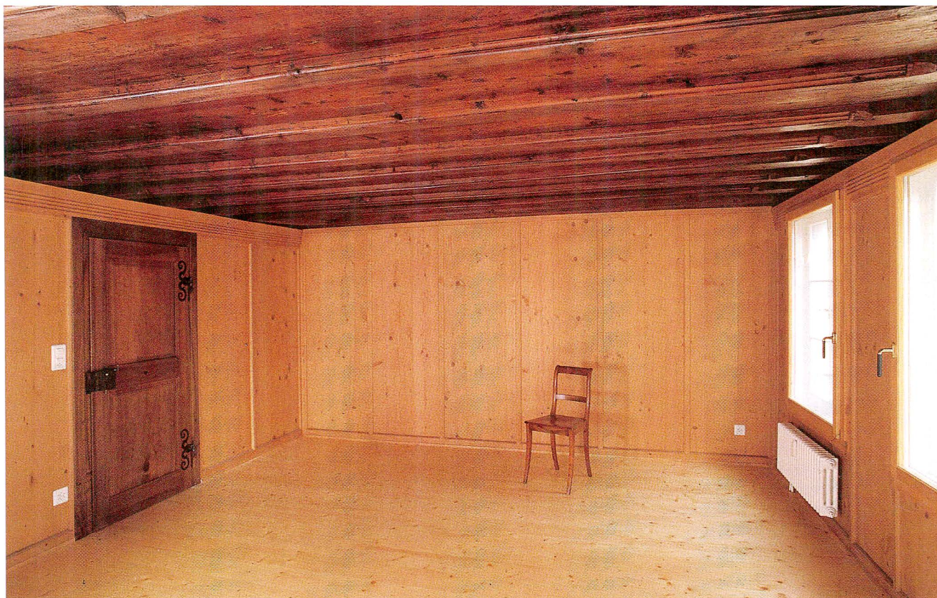
Abb. 22 Zug, St.-Oswalds-Gasse 16/18. Blick Richtung Norden in den Nordost-Raum im 1. Obergeschoss des Kernbaues, nach der Restaurierung.
