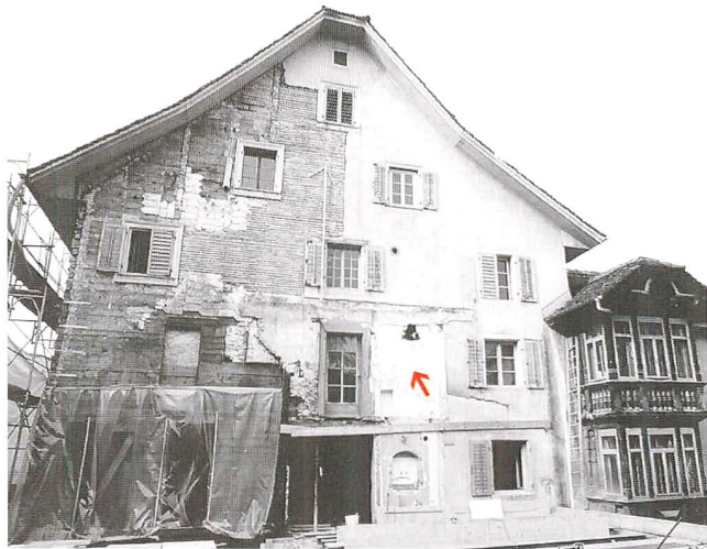
Abb. 5 Zug, St.-Oswalds-Gasse 16/18. Blick Richtung Süden auf die Nordfassade oberhalb des Erdgeschosses, Zustand 1993. Rechts sind die West-Anbauten zu erkennen. Der Pfeil markiert die Stelle, wo sich auf dem Aussenputz in schwachen Resten die aufgemalte Jahreszahl «1576» gefunden hat.
