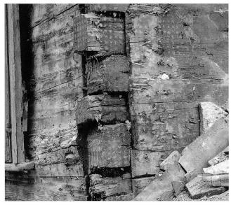
Abb. 12 Zug, St.-Oswalds-Gasse 16/18. Haus Nr. 16, Blick Richtung Südwesten auf die Nordostecke des Blockbaues. Nachträglich abgesägte Balkenvorstösse im 2. Obergeschoss.
