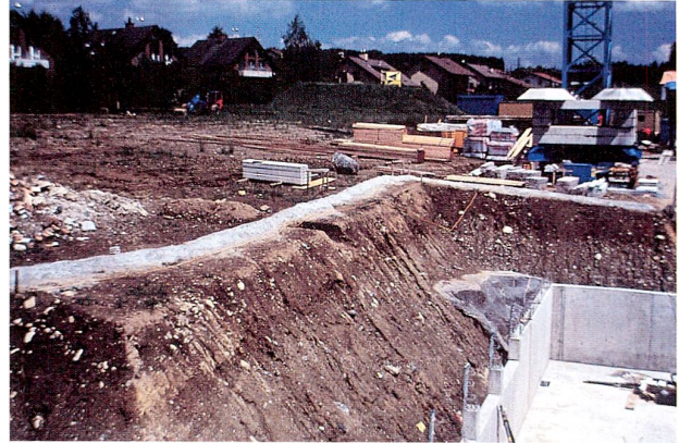
Abb. 10 Steinhausen-Eschenmatt. Blick von Osten auf den Nordrand der Baugrube mit Schnitt 1.
