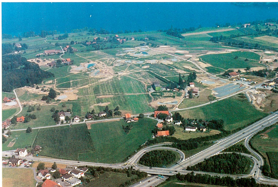
Abb. 17 Risch, Holzhäusern, Golfpark Sonnhalde. Blick auf die Baustelle gegen Osten.
