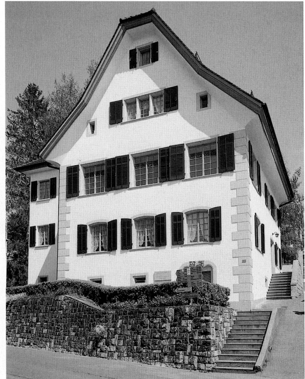
Abb. 14 Oberägeri. Das Zurlaubenhaus von Süden nach der Aussenrestaurierung, 1995.
