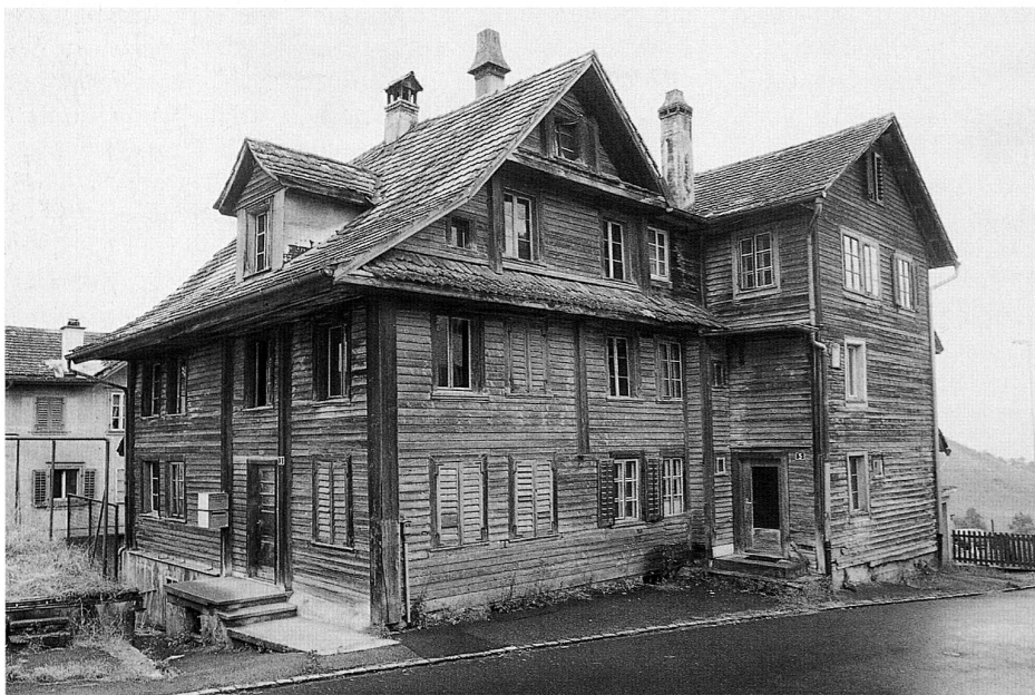
Abb. 12 Menzingen, Seminarstrasse 3/5. Blick Richtung Südwesten, Zustand vor dem Abbruch im Juli 1994; links Kernbau vom Herbst/Winter 1767/68.
