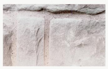
Abb. 5a/b Zug, Pfarrkirche St. Michael. Offene, ausgefallene Fugen. Neu verfugtes Mauerwerk.
