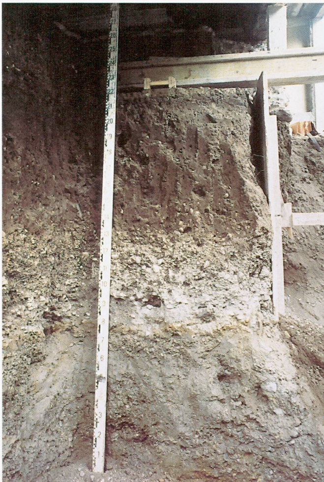
Abb. 31 Zug, Oberwil, Artherstrasse 109, Wohnhaus. Ausschnitte des bei der Unterkellerung beobachteten Profils; Blick Richtung Westen. Knapp unterhalb «22» auf der Messlatte ist das genannte Lehmband zu erkennen, darunter folgt (in einer im wesentlichen dreifachen Schichtung) der gewachsene Boden, ohne erkennbare anthropogene Eingriffe.
