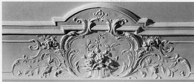
Abb. 26 Zug, Artherstrasse 20. Detail der Stuckdekoration aus dem Jahr 1900. Aufnahme nach der Restaurierung 1993.
