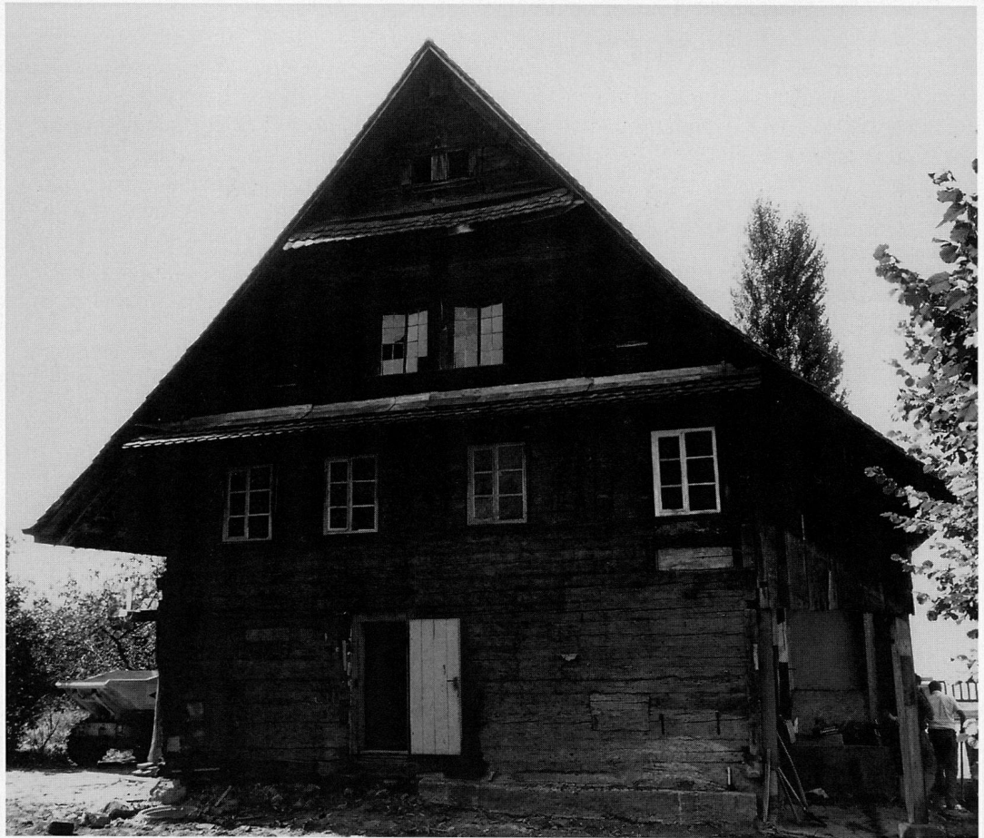
Abb. 30 Zug, Oberwil, Artherstrasse 109, Wohnhaus. Ansicht der Ostfront (Hinterhaus) vor der neuen Unterkerlerung; die traufseitigen Anbauten sind bereits entfernt.
