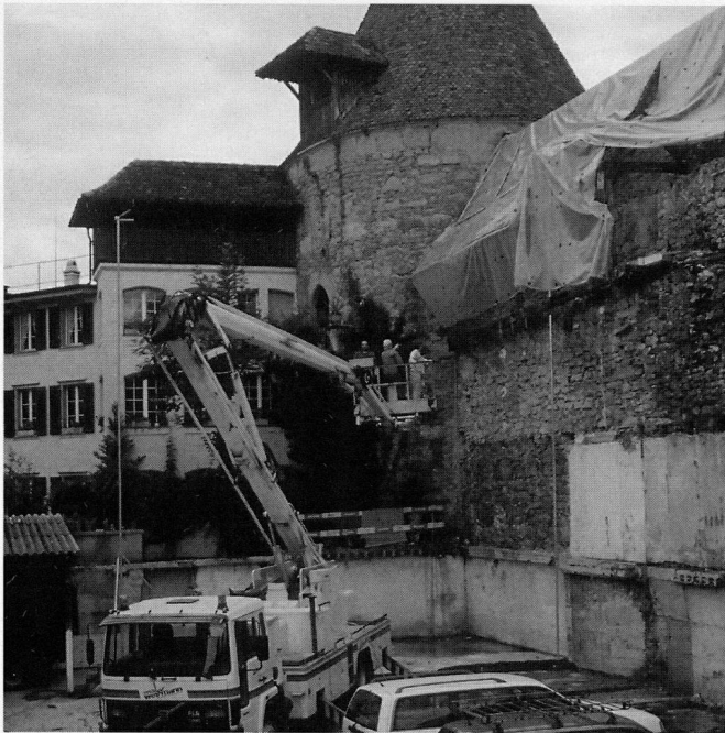
Abb. 23 Zug, Quartier Dorf. Blick Richtung Nordosten auf die Innenseite der dritten Stadtmauer. Entnahme von Dendroproben an den vom Brand verschonten Resten der hölzernen Wehgangbedachung.
