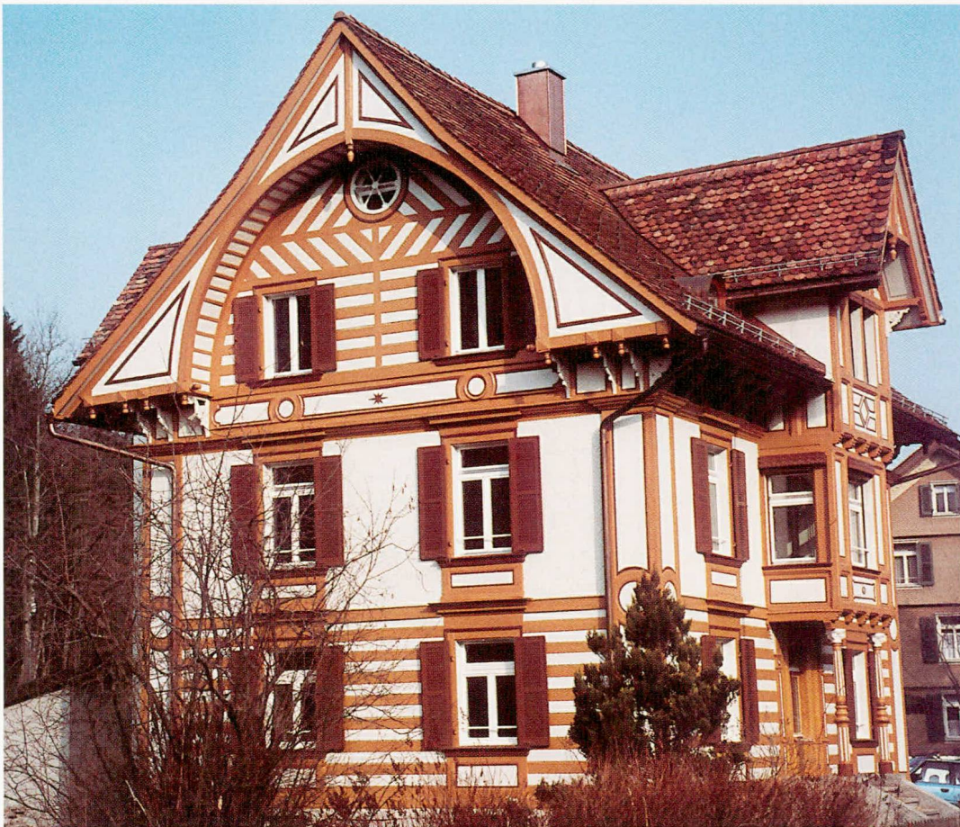
Abb. 18 Unterägeri, Zugerstrasse 181, Direktorenhaus der Spinnerei Neuägeri. An- sicht nach der Restau- rierung, 1993, von Südosten.
