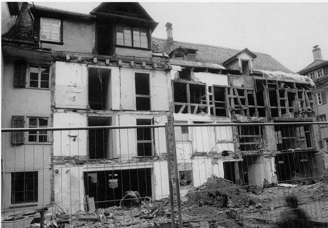
Abb. 40 Zug. Blick Richtung Westen auf die Ost-, d. h. Rückfronten der Häuser Zeughausgasse 3 und 5, erbaut nach 1795; Zustand nach Abbruch der rückwärtigen jüngeren Anbauten.
