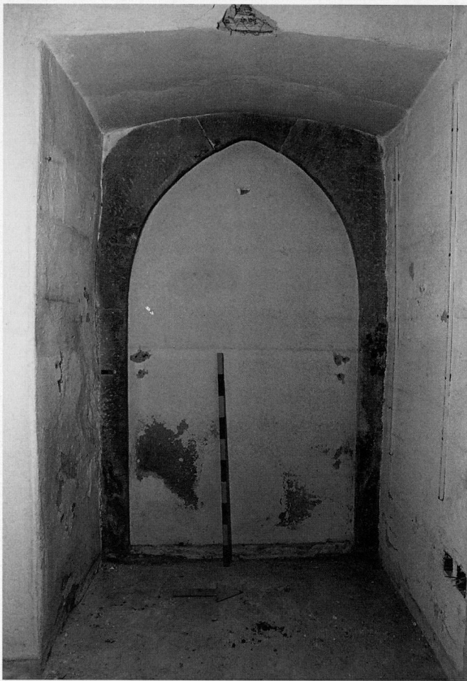
Abb. 35 Zug, Haus «beim Süsswinkel», früher Ass. Nr. 112, heute Ass. Nr. 130b. Blick Richtung Westen auf die Innenseite der Westwand. Spitzbogiger Eingang, der bei Renovierungsarbeiten Mitte des 19. Jahrhunderts vermauert wurde und bei den Umbauten des Jahres 1993 wieder eingesehen werden konnte.
