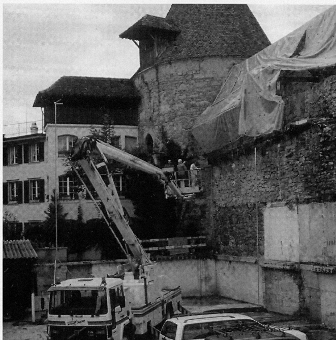
Abb. 23 Zug, Quartier Dorf. Blick Richtung Nordosten auf die Innenseite der dritten Stadtmauer. Entnahme von Dendroproben an den vom Brand verschonten Resten der hölzernen Wehrgangbedachung.
