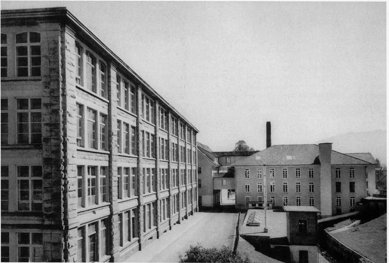
Abb. 19 Unterägeri, Innere Spinnerei. Fabrikneubau von 1908 an der Zugerstrasse.
