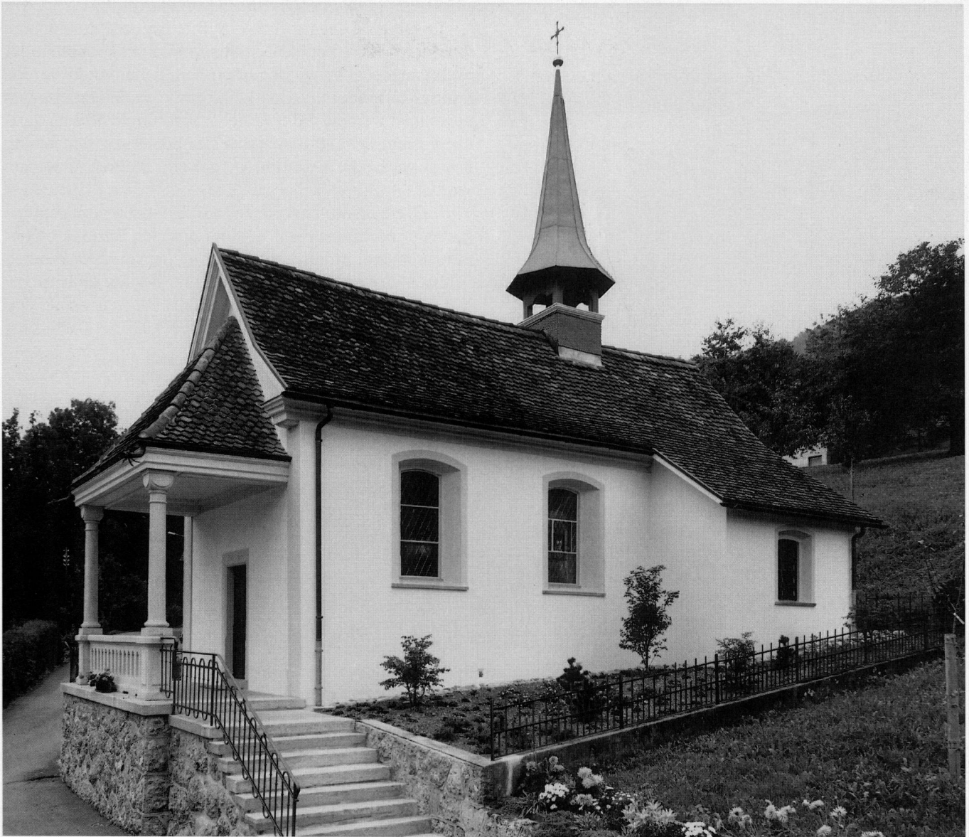
Abb. 22 Walchwil, Antoniuskapelle im Oberdorf von Süden, nach der Restaurierung 1993.
