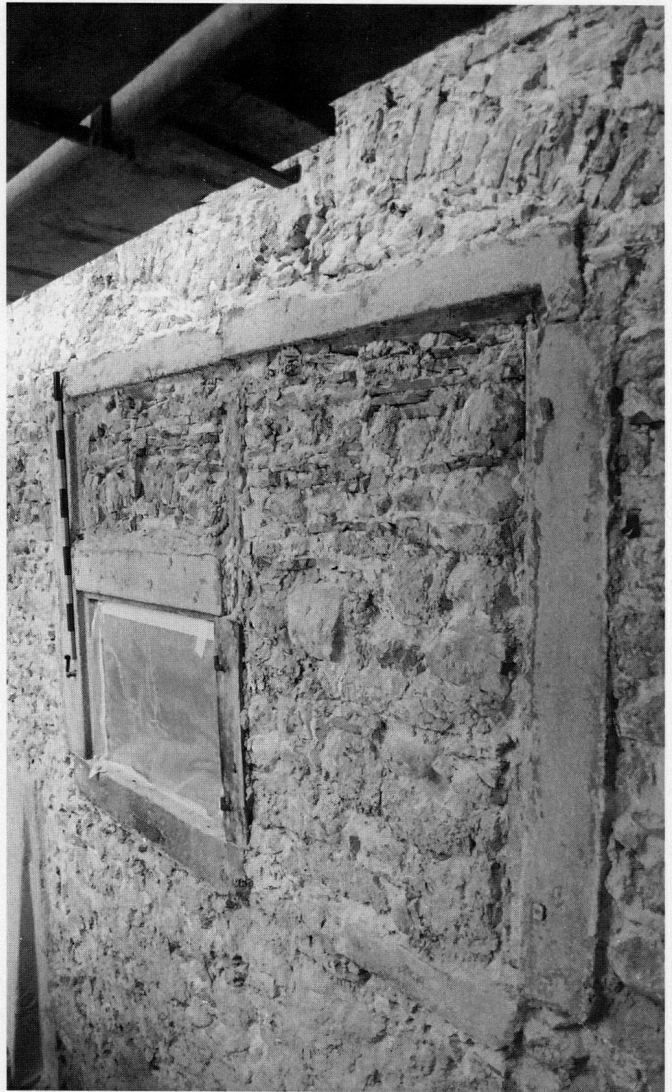
Abb. 42 Zug, Münz. Durch Entfernung des deckenden Putzes wird ein älteres Fenster in der südlichen Innenhoffassade wieder sichtbar.
