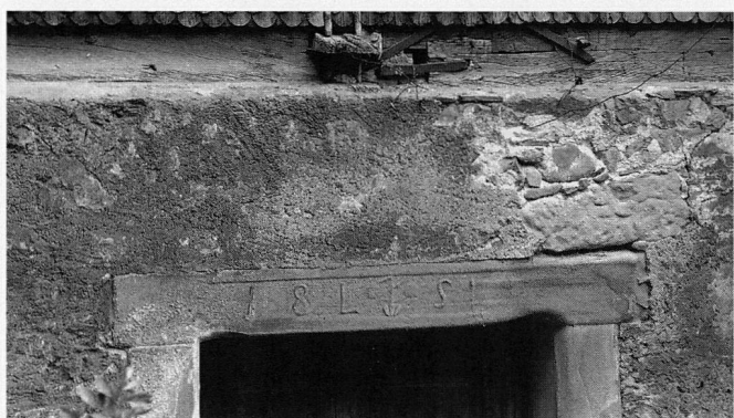
Abb. 7 Cham, Haus Obermühle. Türsturz über dem Kellereingang an der Südseite des Hauses, aufgenommen 1985; die angegebene Jahreszahl dürfte als 1817 aufzulösen sein. – Auf der jünger untergestellten Kellerwand liegt die Schwelle der Südfassade: Links ein originaler Rest mit Schwellenschloss, dendrodatiert Herbst/Winter 1591/1592; rechts der genannte Mittelflick mit Eisenarmierungen als Unterlage des (auf dem Foto durch die Schindeln verdeckten) Mittelständers, dendrodatiert Herbst/Winter 1811/1812.
