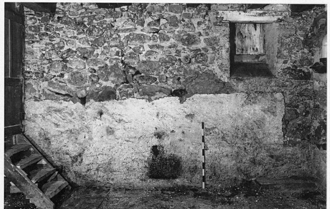
Abb. 11 Cham, Haus Obermühle, Untergeschoss. Blick auf die Nordhälfte der Westwand, innen, nach teilweiser Putzentfernung. Sichtbar wird das ältere Mauerwerk sowie (oben rechts) ein nachträglich eingebrochenes Fenster; Zustand 1992.
