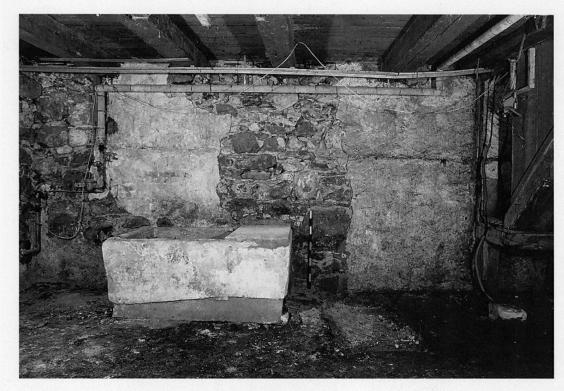
Abb. 12 Cham, Haus Obermühle, Untergeschoss. Blick auf die Südhälfte der Westwand, innen, nach teilweiser Putzentfernung. Sichtbar wird das ältere Mauerwerk sowie eine vor die Wand gestellte Wanne, deren Zweck und Zeitstellung nicht sicher zu bestimmen sind; Zustand 1992.
