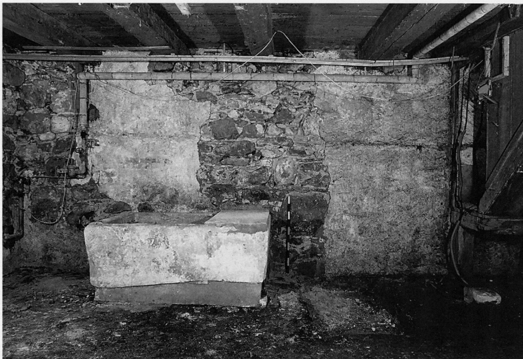
Abb. 12 Cham, Haus Obermühle, Untergeschoss. Blick auf die Südhälfte der Westwand, innen, nach teilweiser Putzentfernung. Sichtbar wird das ältere Mauerwerk sowie eine vor die Wand gestellte Wanne, deren Zweck und Zeitstellung nicht sicher zu bestimmen sind; Zustand 1992.
