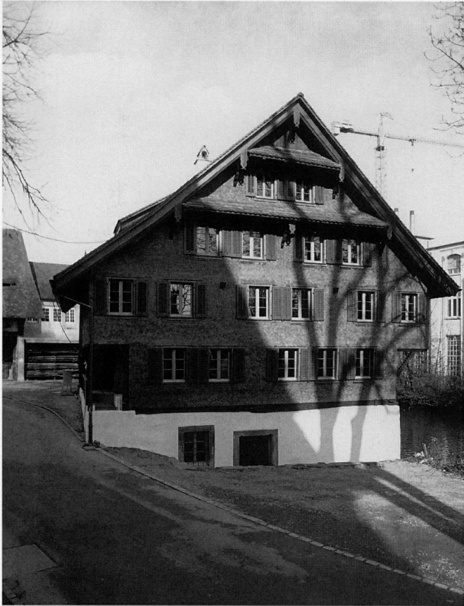
Abb. 22 Cham, Haus Obermühle. Blick von Westen, nach der Restaurierung, 1993.
