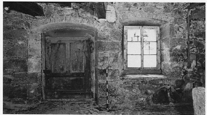
Abb. 10 Cham, Haus Obermühle. Untergeschoss, Blick Richtung Süden auf die Westhälfte der Innenseite der Südwand; aktuelle Eingangssituation und Fenster, Zustand 1992. Leibungen mit Eckquadern aus Sandstein, mit Stichbögen aus rotem Backstein überwölbt.
