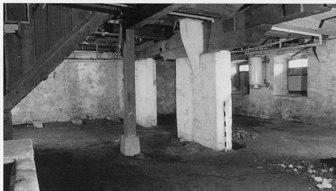
Abb. 9 Cham, Haus Obermühle. Untergeschoss, Blick Richtung Nordost, Zustand 1992.
