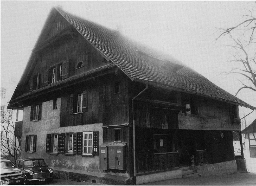
Abb. 3 Cham, Haus Obermühle. Blick auf die Nordwest- Ecke in Richtung Südosten, Zustand 1978.
