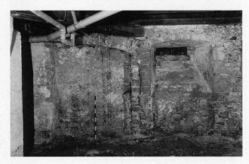
Abb. 14 Cham, Haus Obermühle, Untergeschoss. Blick auf den östlichen Teil der Innenseite der Nordmauer. Links ein vermauertes grosses Tor, rechts der Rest eines Fensters bzw. einer Tür.
