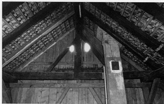
Abb. 20 Cham, Haus Obermühle. Blick Richtung Norden in den Dachstuhl, Zustand 1990.
