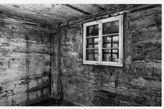
Abb. 18 Cham, Haus Obermühle, Erdgeschoss, Nordwest-Raum. Perspektive ähnlich der vorhergehenden Abbildung, nach Freilegungsarbeiten 1990. Erkennbar werden die alten Fensterpfosten seitlich neben dem aktuellen Fenster, das den Standort beibehalten hat.
