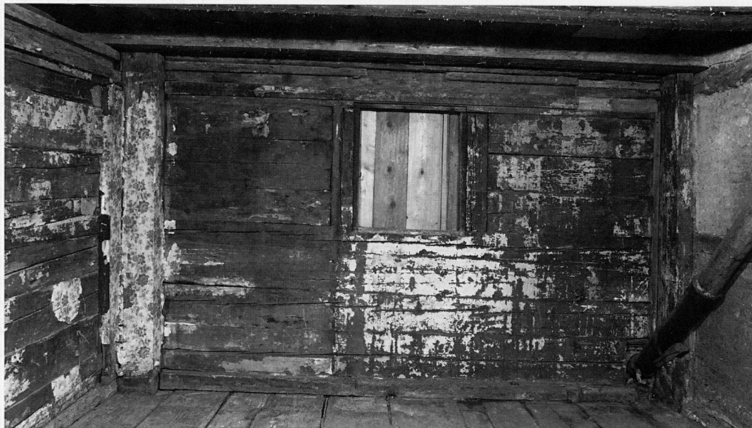
Abb. 19 Cham, Haus Obermühle, 1. Obergeschoss, Nordwest- Raum. Blick auf die West- wand mit dem zugesetzten Originalfenster. Links im Bild der dendrodatierte nördliche Mittelständer der Westfassade (1591/1592), mit den mehrfach aufsitzen- den Schichten verschiede- ner Tapeten; nach Frei- legungsarbeiten 1990.
