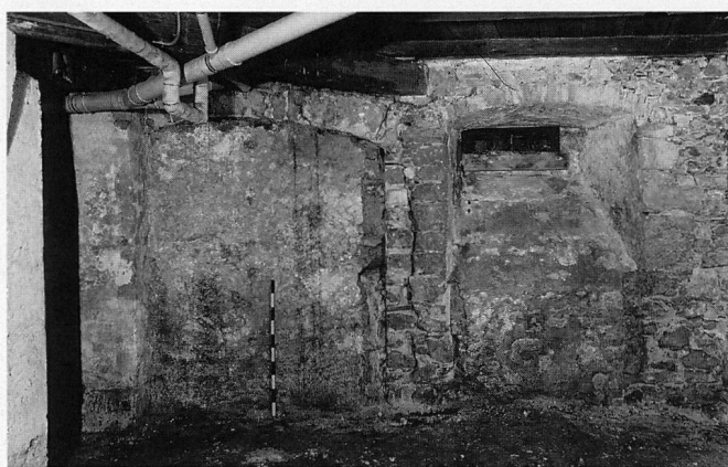
Abb. 14 Cham, Haus Obermühle, Untergeschoss. Blick auf den östlichen Teil der Innenseite der Nordmauer. Links ein vermauertes grosses Tor, rechts der Rest eines Fensters bzw. einer Tür.
