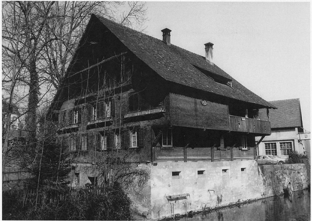
Abb. 4 Cham, Haus Obermühle. Blick auf die Südost-Ecke in Richtung Nordwesten, Zustand 1978.
