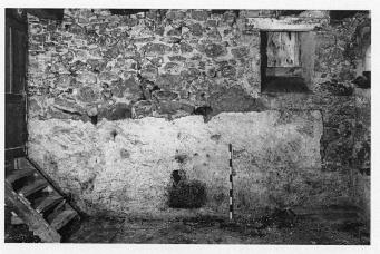
Abb. 11 Cham, Haus Obermühle, Untergeschoss. Blick auf die Nordhälfte der Westwand, innen, nach teilweiser Putzentfernung. Sichtbar wird das ältere Mauerwerk sowie (oben rechts) ein nachträglich eingebrochenes Fenster; Zustand 1992.
