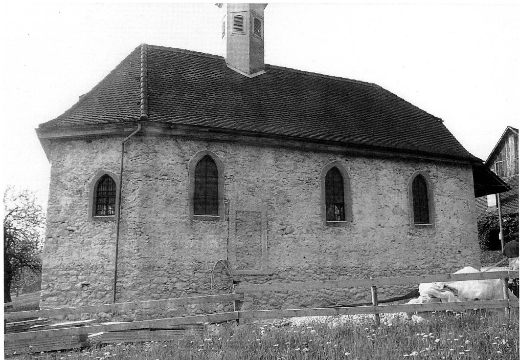
Abb. 18 Risch, Kapelle St. German. Blick auf die Nordseite nach der Entfernung des Verputzes, Mai 1992; erkennbar sind die Fenstergewände und die zuvor verdeckte Seitentür.
