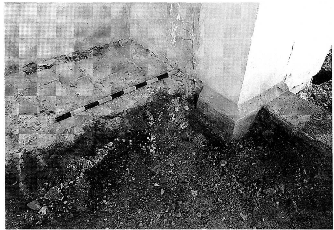
Abb. 19 Risch, Kapelle St. German. Blick Richtung Südwesten an die Innenseite des Chorraumes; nach Entfernung des aktuellen Betonbodens zeigte sich ein älterer Boden aus Tonplatten, dessen Abdrücke deutlich zu erkennen sind, April 1992.
