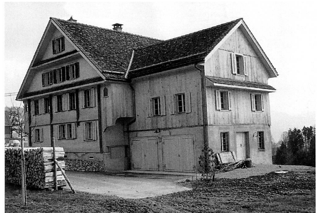
Abb. 17 Oberägeri, Alosen, Bauernhaus Althus. Ansicht von Nordwesten nach der Restaurierung, 1992.
