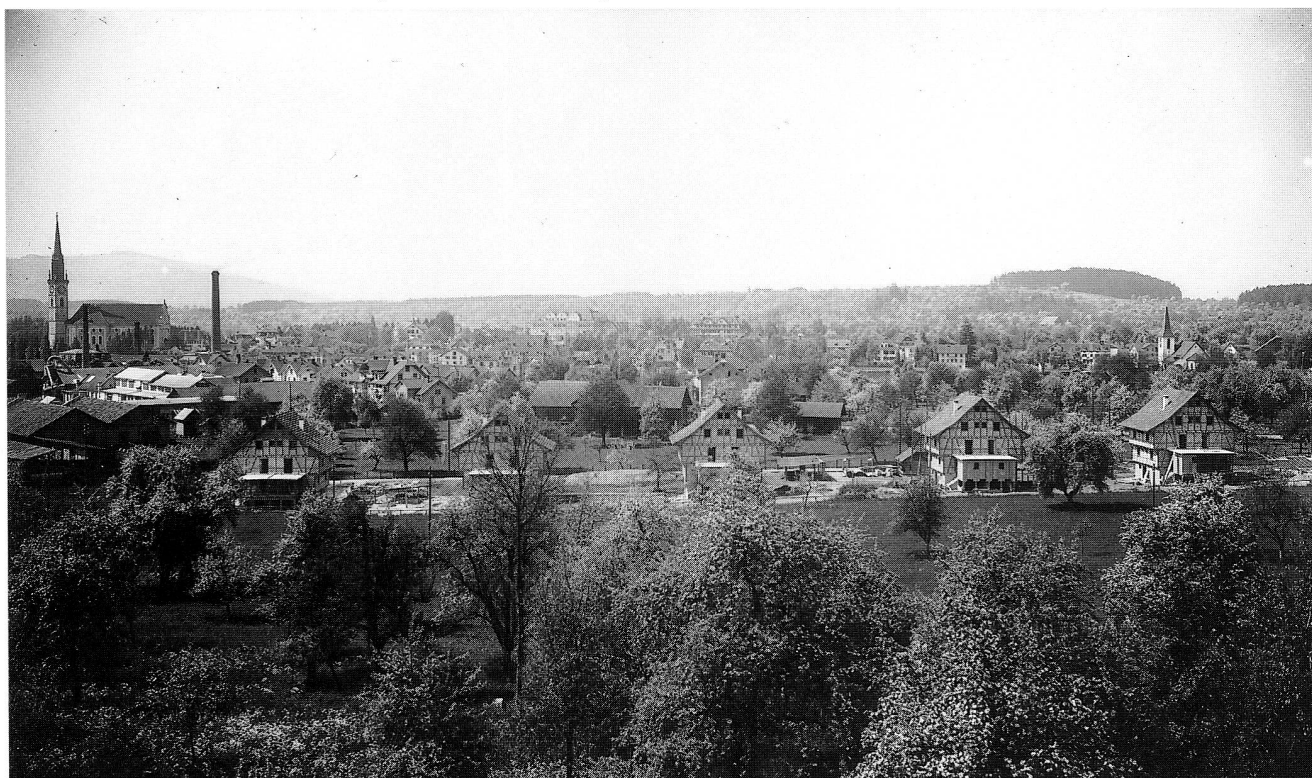
Abb. 6 Cham, Gartenstrasse. Die Arbeitersiedlung kurz vor der Vollendung, 1924, von Nordosten.
