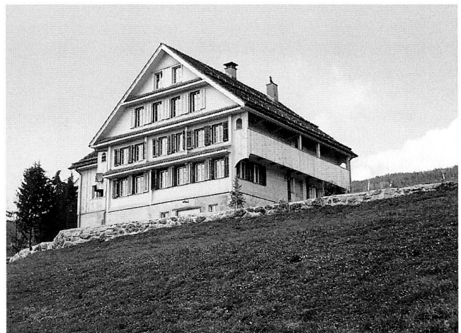
Abb. 16 Oberägeri, Alosen, Bauernhaus Althus. Ansicht von Südosten nach der Restaurierung, 1992.
