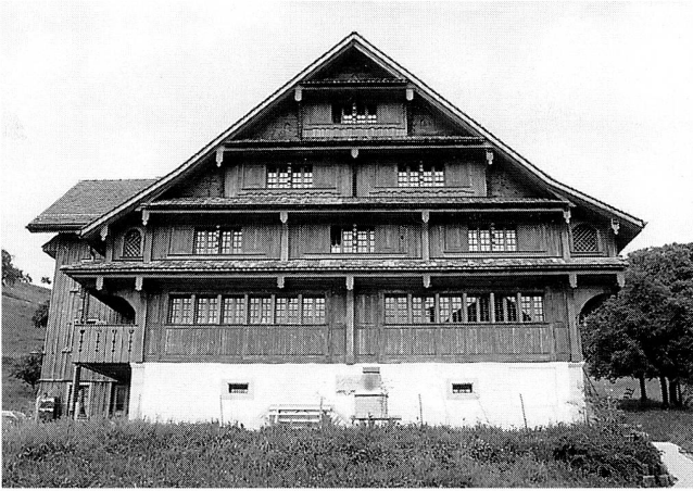
Abb. 14 Oberägeri, Bauernhaus Chrüzibuech. Ansicht von Süden, nach der Restaurierung, 1992.
