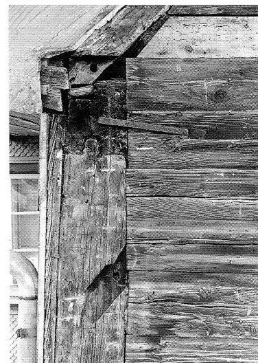
Abb. 13 Menzingen, Restaurant Ochsen, Neudorfstrasse 11. Blick Richtung Westen auf die Südostecke des Altbaues, 1. Obergeschoss. Nach Abnahme der letzten Verkleidungen werden der originale Übergang von der Dachkonstruktion zum Eckständer, aber auch verschiedenste nachträgliche Änderungen sichtbar, wie die Ausfachungen rechts; Zustand vor dem Abbruch Februar 1992.
