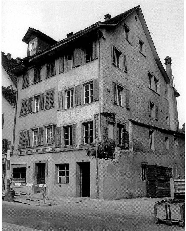
Abb. 30 Zug, St. Oswaldsgasse 2 (rechter) und 4 (linker Hausteil); Blick Richtung Westen, Zustand April 1992. An der Hausecke ist die ursprüngliche Ständerkonstruktion teilweise freigelegt.
