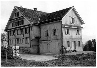
einheitlich mit vertikalen Brettern verkleidet, so dass er sich dem Hauptbau unterordnet. Das Bruchsteinmauerwerk des Untergeschosses erhielt einen neuen Aussenverputz, der nicht gestrichen wurde. Das Gebäude ist von innen her mit einer Wärmedämmung versehen worden, wobei das Dach als Kaltdach belassen wurde. Das Wohnhaus wird weiterhin als Einfamilienhaus genutzt.
