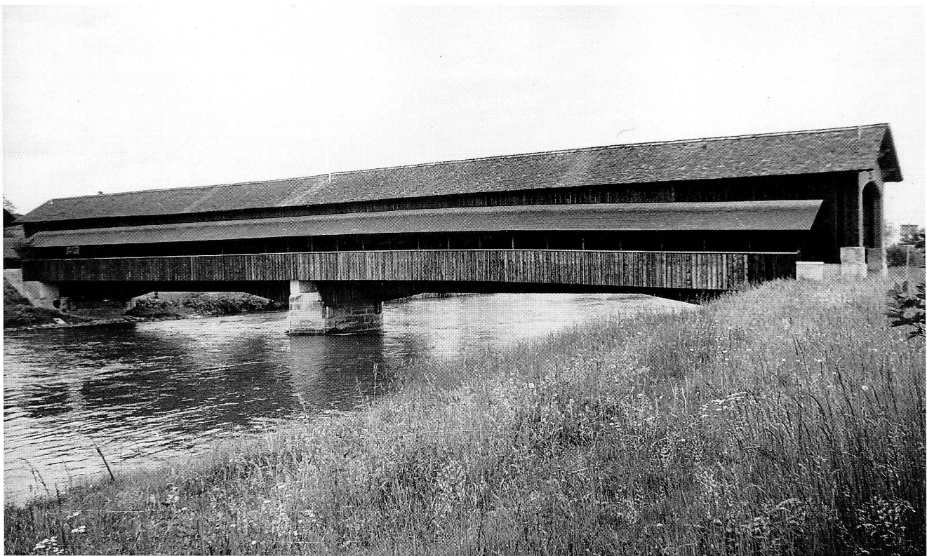
Abb. 10 Hünenberg, Holzbrücke über die Reuss bei Sins, Zustand nach der Erweiterung durch einen Fussgängersteg, 1946.
