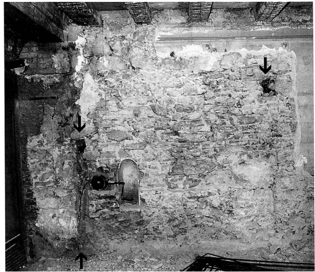
Abb. 5 Stadt Zug, Ägeristrasse 9, Erdgeschoss. Blick Richtung Westen auf die Süd Hälfte der Westwand (= Trennwand zu Haus 7); aufgenommen 1989. Unter dem abgelösten modernen Verputz fanden sich ein Balkenkopf-Negativ (Pfeil rechts) sowie die Reste eines eingemauerten Balkchens (Pfeile links).
