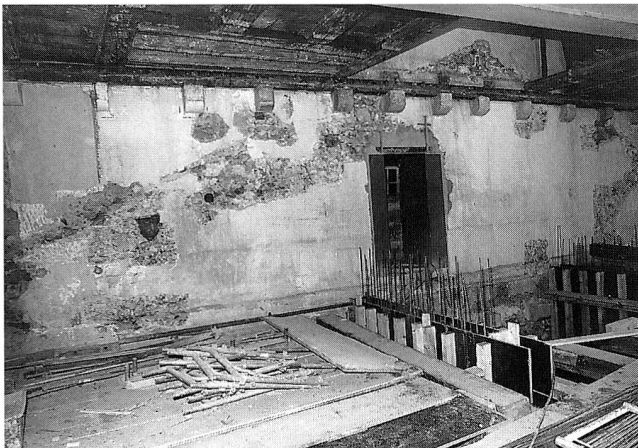
Abb. 8 Stadt Zug, Ägeristrasse 7. Blick Richtung Osten auf das Negativ der Dachschräge der abgegangenen Bebauung; aufgenommen 1989.
