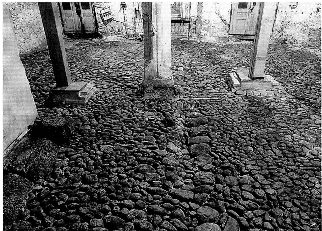
Abb. 10 Stadt Zug, Ägeristrasse 7. Blick Richtung Süden in das Erdgeschoss: Originalpflasterung des Alten Zeughauses mit streifiger Einteilung; in der Bildmitte der originale Mittelständer, daneben zwei moderne Stützen; aufgenommen 1989.
