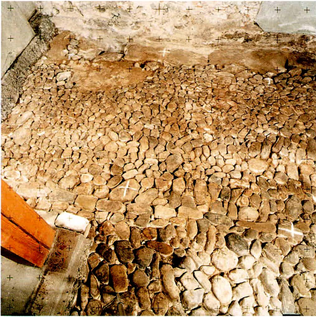
Abb. 22 Stadt Zug, Ägeristrasse 7. Messbildaufnahme mit 4 Passpunktkreuzen.
