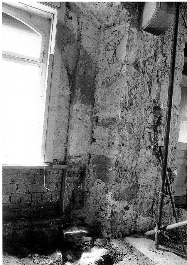
Abb. 12 Stadt Zug, Ägeristrasse 7, Erdgeschoss. Blick Richtung Süden auf den Mittelteil der inneren Südfassade; aufgenommen 1989. Das ursprüngliche grosse Portal vom Zeughaus wurde später zum Fenster verkleinert.
