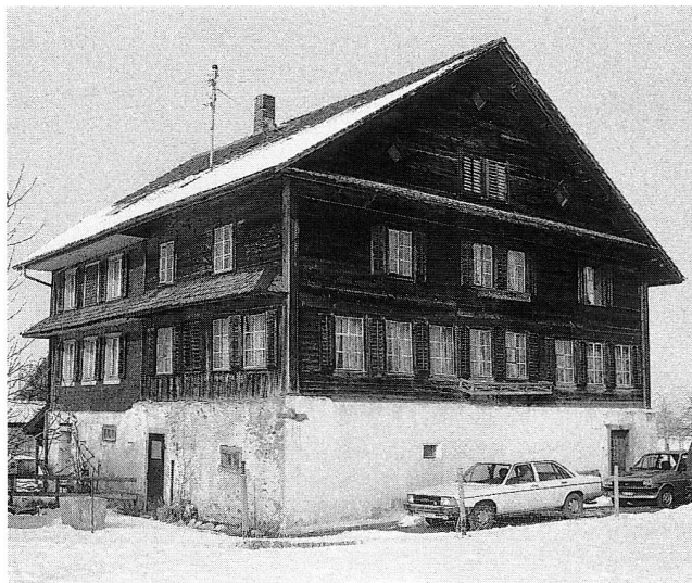
Abb. 1 Neuheim, Hinterburg, Haus «Spittel». Ansicht von Süden, Zustand vor dem Umbau.
