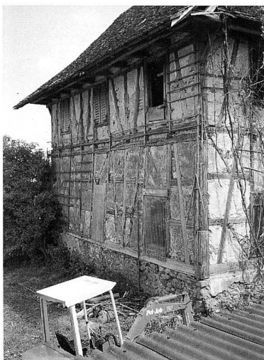
Abb. 10 Hünenberg, Trotte in St. Wolfgang. Vor der Restaurierung.
