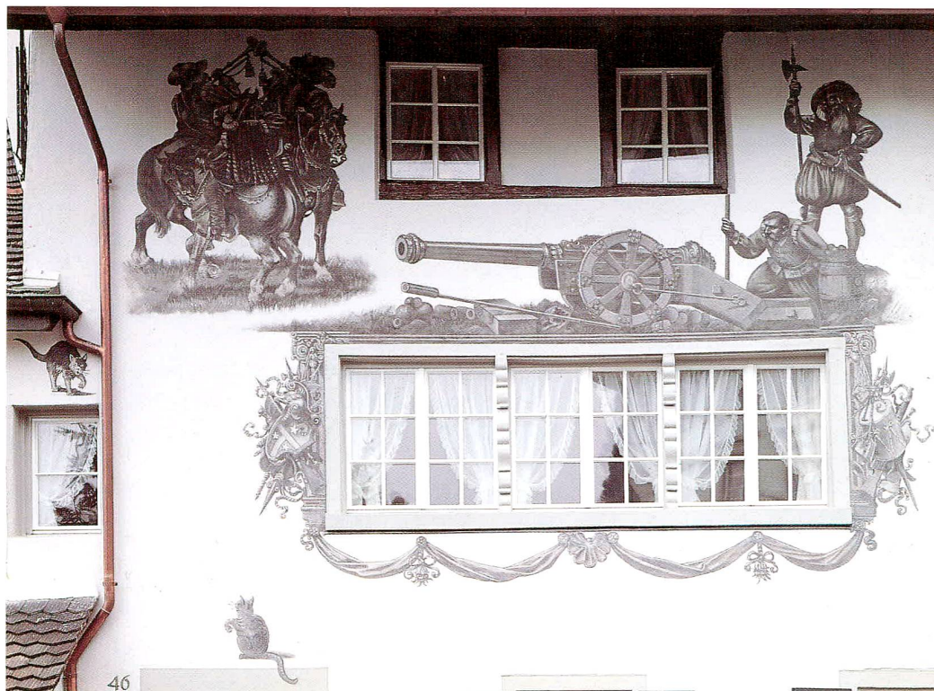
Abb. 23 Zug, Grabenstrasse 46. Das «Kanonenhaus» nach der Restaurierung 1991.
