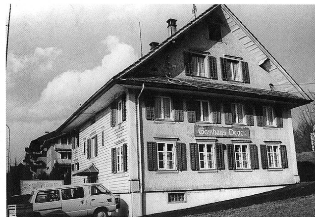
Abb. 6 «Degen», Hünenberg. Aussenansicht am Standort der Verschiebung über die Strasse, 1988–1990.
