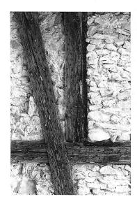
Abb. 4 Zug, Kloster Maria Opferung: Nuten der ursprünglichen Schlitzfenster im Obergeschoss, Südwand.
