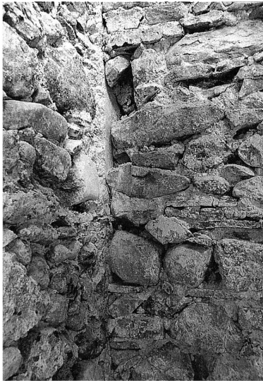
Abb. 7 Zug, Kloster Maria Opferung: Blick von Südwesten in die Nordostecke des Kreuzganges; rechts östliche, links nördliche Innenflucht.
