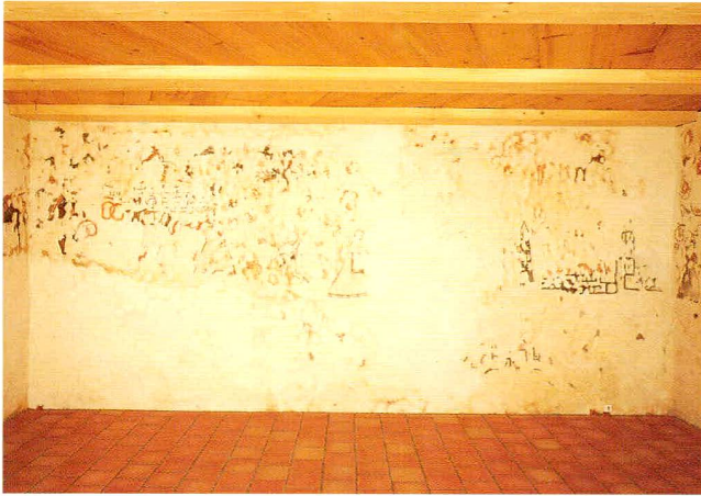
Abb. 9 Zug, Dorfstrasse 6/8. Bäckerzene. Wandmalereien an der Nordwand des Gotischen Saales, 1535 datiert. Zustand nach der Restaurierung.
