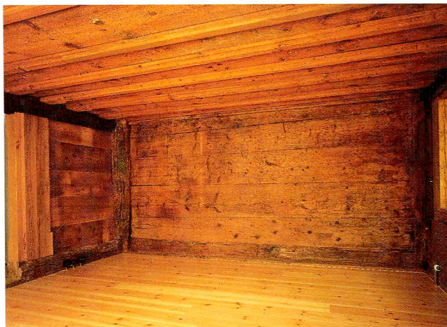
Abb. 3 Zug, Dorfstrasse 6/8. Blick in Stube des Ständerbohlenhauses nach der Restaurierung, 1991.
