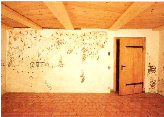
Abb. 10 Zug, Dorfstrasse 6/8. Kreuzigung Christi und Kirche mit Beinhaus und Friedhof. Wandmalereien an der Ostwand des Gotischen Saales, 1535 datiert. Zustand nach der Restaurierung.
