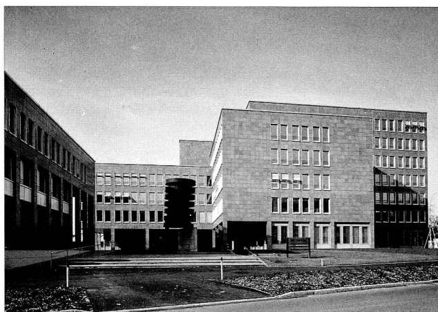
Abb. 1 Blick von Osten in den Innenhof des kantonalen Verwaltungszentrums an der Aa. Gerichtsgebäude (links). Verwaltungsgebäude 1. Im Erdgeschoss des Ost- (Bildmitte) und Nordflügels (rechts) sind der Lesesaal und die Verwaltung des Staatsarchivs untergebracht.
