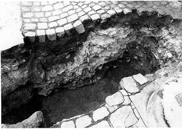
Abb. 19 Zug, Löberntor. Ansicht der Nordostecke der südöstlichen Flanke mit der 1986 angetroffenen Läufer-Binder-Quadratur aus Bossenquadern; Blick von Nordosten.
