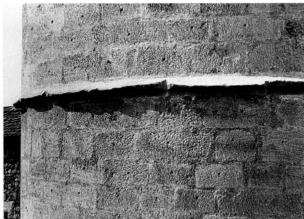
Abb. 50 Zug, Kapuzinerturm. Detail eines restaurierten Stockwerkgurtes, 1991.
