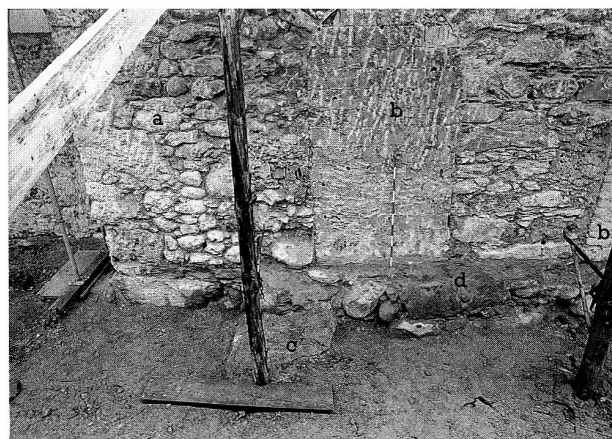
Abb. 12 Neuheim, Beinhause St. Josef und Maria. Ansicht des freigelegten Ostteiles (a) der Nordfassade mit zugemauertem Durchlass (b), Rest des abgebrochenen Nordraumes (c) und vorspringendem Fundament (d).
