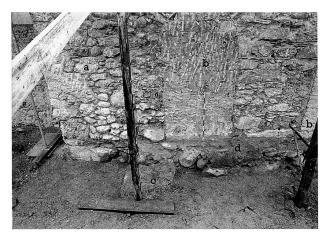
Abb. 12 Neuheim, Beinhaus St. Josef und Maria. Ansicht des freigelegten Ostteiles (a) der Nordfassade mit zugemauertem Durchlass (b), Rest des abgebrochenen Nordraumes (c) und vorspringendem Fundament (d).
