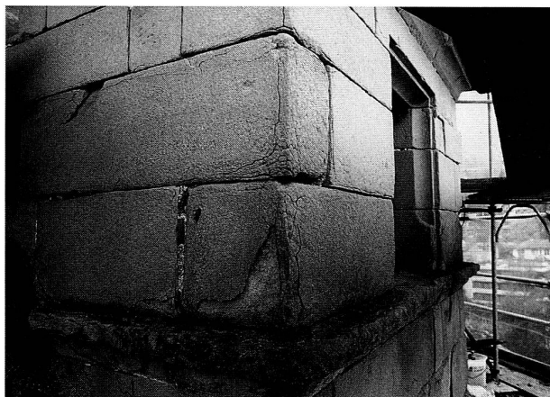
Abb. 49 Zug, Kapuzinerturm. Typisches Schadenbild, 1987.
