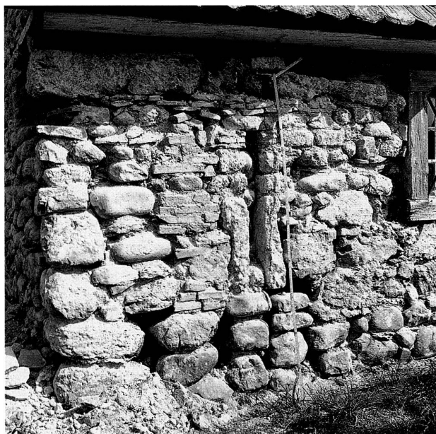
Abb. 3 Neuheim, Kapelle St. Wendelin. Nordhälfte des westlichen Längswand nach Entfernung des Verputzes. Aufnahme 1978.
