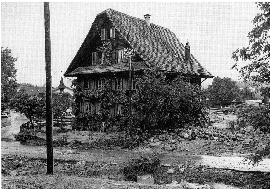
Abb. 4 Baar, Inwil, Talacher- strasse 27. Ansicht von Süd- osten vor der Restaurierung, sichtbar sind die Schäden des Unwetters vom 17. Juni 1986.
