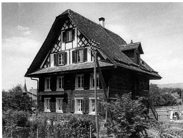
Abb. 5 Baar, Inwil, Talacherstrasse 27. Ansicht von Südosten nach der Restaurierung, 1989.
