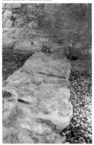
Böden: Im Chor deuteten einige Reste von Tonplättchennegativen auf einen ehemaligen Boden hin. Vom Sandsteinplattenboden von 1844 blieben Teile nur im Chor erhalten, weil darauf die «Herrenstühle» gestanden hatten (Abb. 23)9. Damals wurde die gesamte Kirche mit neuen Sandsteinplatten ausgelegt, wie aus den Rechnungen hervorgeht<sup>10</sup>.
