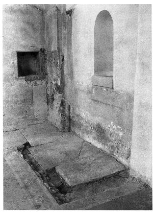
Abb. 23 Baar, Allenwinden, Kirche St. Wendelin. Chor mit Rest des Sandsteinplattenbodens von 1844.
