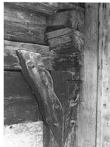
Abb. 3 Baar, Kirchgasse 13. Zweites Obergeschoss, Giebelseite West. Kopfstreben eines zweigeschossigen Mittelständers (datiert 1470).
