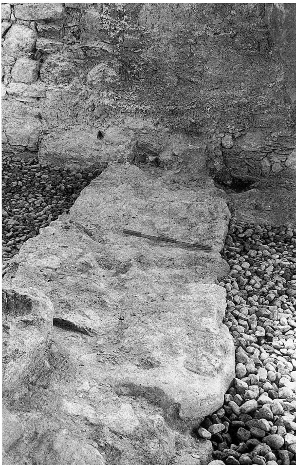
Abb. 22 Baar, Allenwinden, Kirche St. Wendelin. Baunaht an der Südmauer (1701) mit Westmauer (1769).
