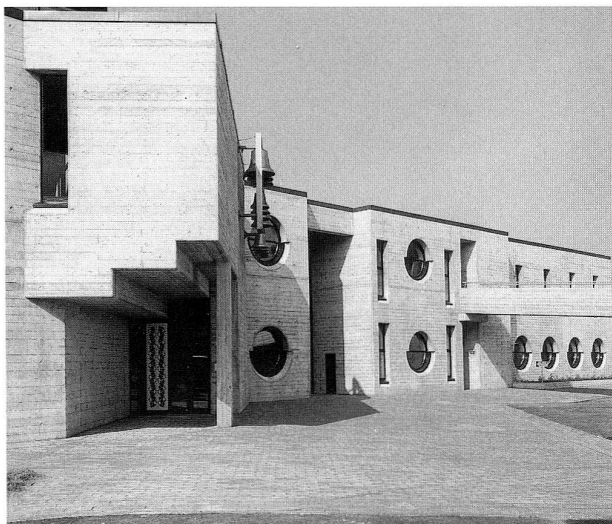
Abb. 29 Steinhausen, Kirchen- und Gemeindezentrum. Blick nach Westen 1981.
