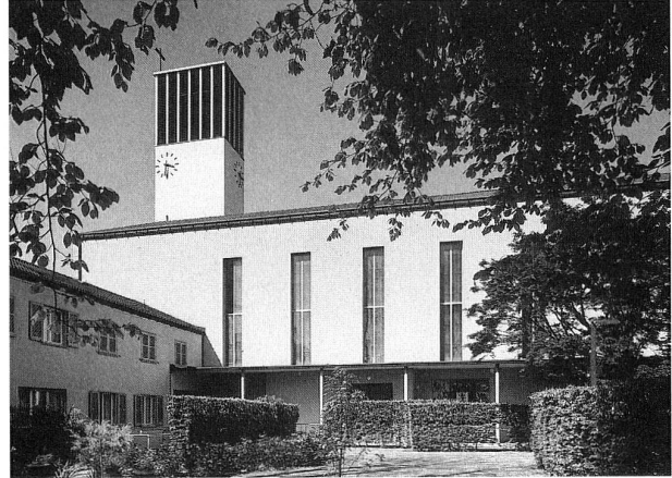
Abb. 4 Zug, Guthirt-Kirche. Ansicht von Süden, 1990.
