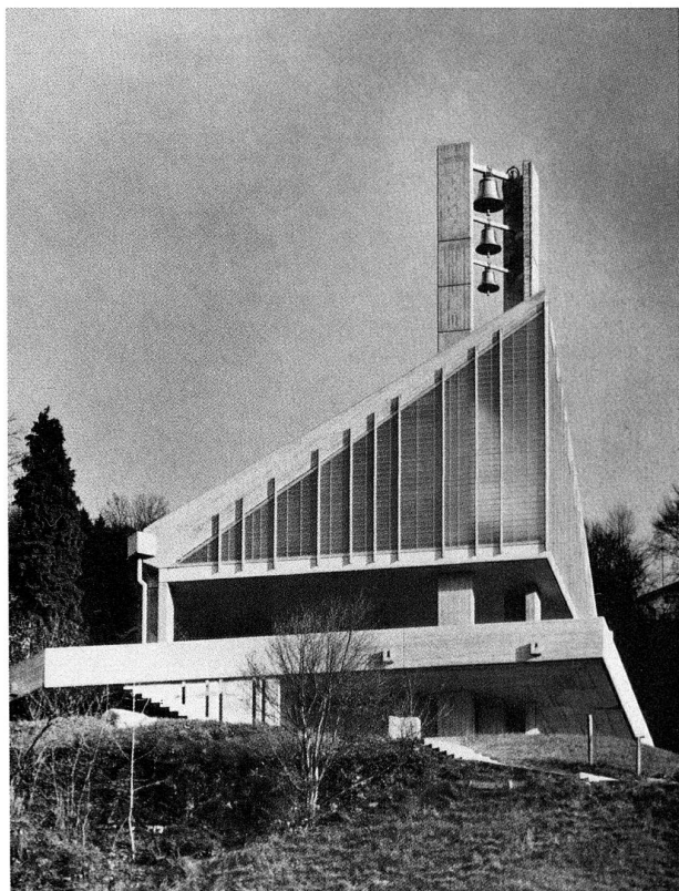
Abb. 14 Walchwil, Reformierte Kirche. Ansicht von Westen 1965.
