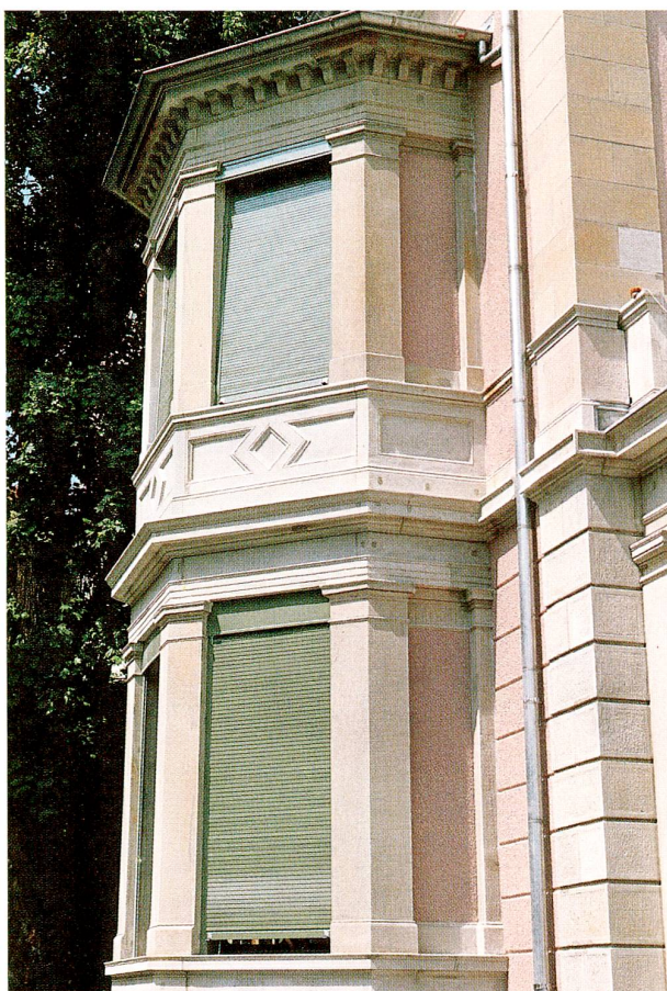
Abb. 60 Cham, Villette. Erker mit sanierten Sandsteinteilen.
