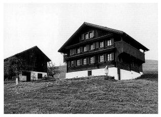
Abb. 15 Unterägeri, Unterzittenbuch. Bauernhaus nach der Restaurierung und Rekonstruktion des originalen Tätschdaches.
