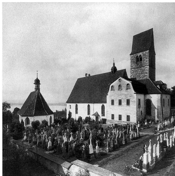
Abb. 28 Alt St. Michael mit Beinhaus: Ansicht von Südosten.
