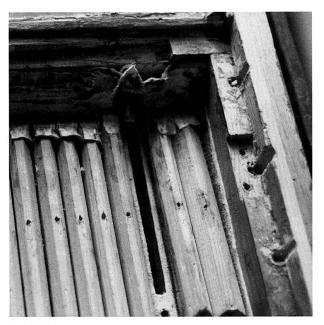
Abb. 104 Zustand der Windlade im Ventilkasten vor der Restaurierung.
