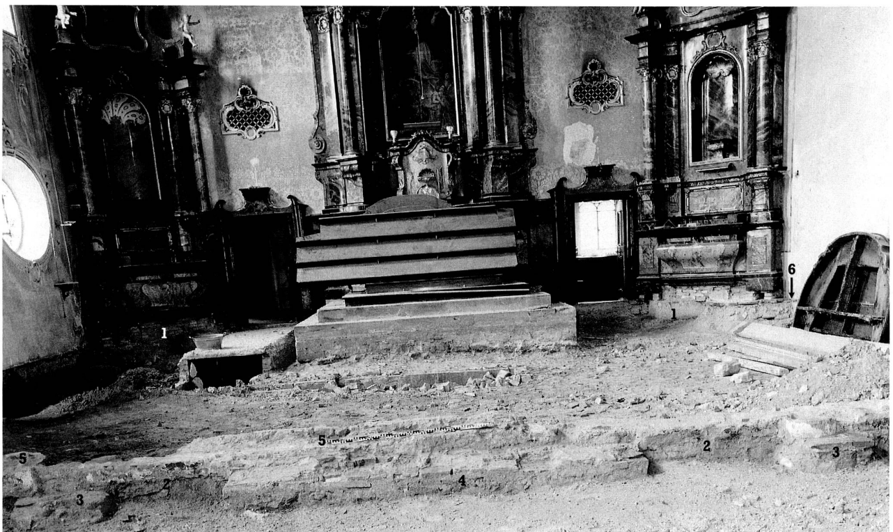
Abb. 97 Blick vom Nonnenchor in den Chorraum. Im Vordergrund die neue Trennmauer, Kirche VI. 1 Seitenaltäre ab Kirche I, 2 Querfundament, Kirche VI, 3 Halbsäulenfundamente, Kirche VI, 4 Vorgesetzte Mittelstufe an 2, 5 Anschlagmäuerchen auf 2, 6 Bodenplatten Kirche VI.
