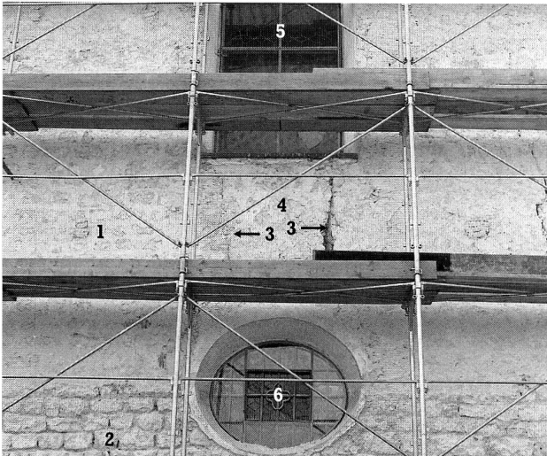
Abb. 63 Ausschnitt der Nordfassade. 1 Mauerwerk mit steinsichtigem Verputz, Kirche I, 2 Wie 1, aber vom Verputz befreit, 3 Negative des romanischen Fensters (des westlichsten), 4 Vermauerungsflick, 5 Rundbogenfester, Kirche VI, 6 Ochsenaugenfenster, Kirche VI.
