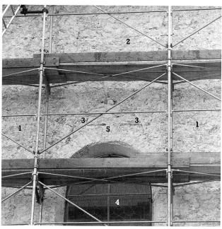
Abb. 82 Detail aus der Westfassade (Mittelfenster). 1 Westwandmauerwerk, Kirche I, 2 Mauerwerk der Aufhöhung, Kirche III, 3 Laibungen des Mittelfensters, Kirche III, 4 Rundbogenfenster der Kirche VI, 5 Versetzflick zu 4.
