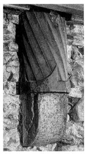
Abb. 37 Zug, Graben 12. Keller, Gotischer Fensterpfosten in sekundärer Verwendung.
