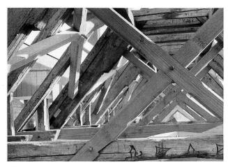
Abb. 17 Zug. Alte Steinhauserbrücke. Ergänzter Dachstuhl unten die angeschnitene Jahrzahl 1712.
