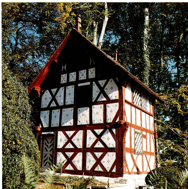
Abb. 11 Risch. Schloss Buonas. «Rebhüsli» mit freigelegtem Fachwerk und schablonierter Ornamentierung der Putzfelder nach der Restaurierung.
