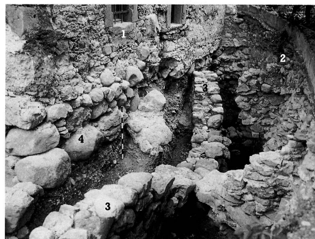
Abb. 6 Zug, Burg. Sondierung 1967. Blick von Südosten in den oberen Hof. 1 Burggebäude, 2 kyburgerzeitliche Ringmauer, 3 ältere, wohl lenzburgerzeitliche Ringmauer, 4 Reste der kyburgischen Schildmauer.
