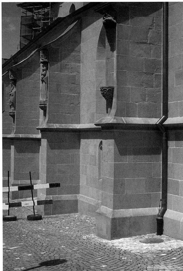
Abb. 1 Zug, Kirche St. Oswald. Südliche Strebepfeiler nach der Sanierung.
