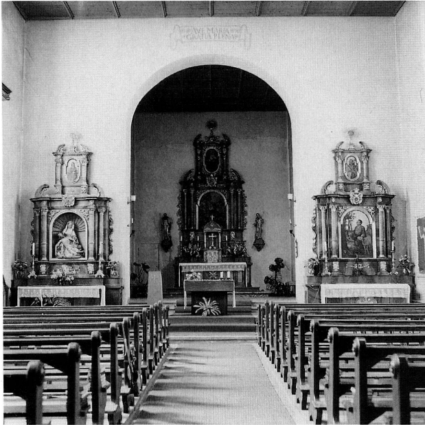
Abb. 16 Baar, Kirche der Internatsschule Walterswil. Zustand vor der Restaurierung.
