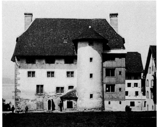
Abb. 28 Zug, Kaserne/Kornhaus, Zustand vor 1894
