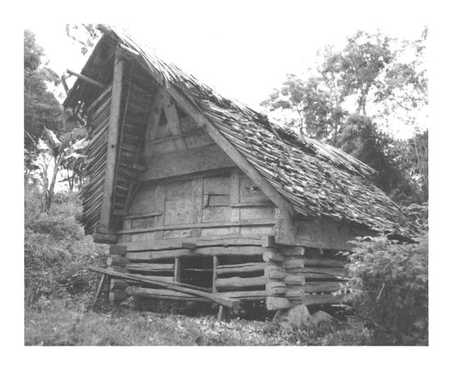
Abb. 2 Einfacher Blockbau (Rückseite) von Tikunna Malenong.
