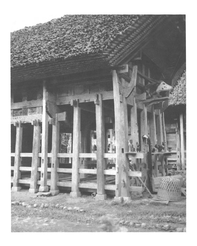
Abb. 4 Bei diesem *tongkonan* in Kesu' ist der ehemals rückwärtig angesetzte Anbau mit seinem höher gelegenen Fussboden, was eine Unterteilung in Kammern zur Folge hatte, deutlich sichtbar. Zu beachten ist hier der *a'riri posi*.
