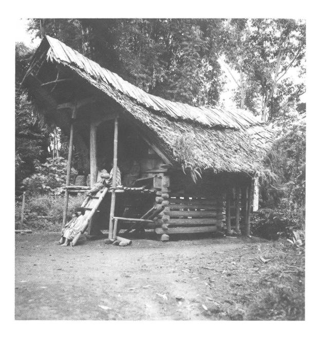
Abb. 3 Blockbau von Lempe, Lolai. Der rückwärtige Anbau ist in Pfostenbauweise ausgeführt.
