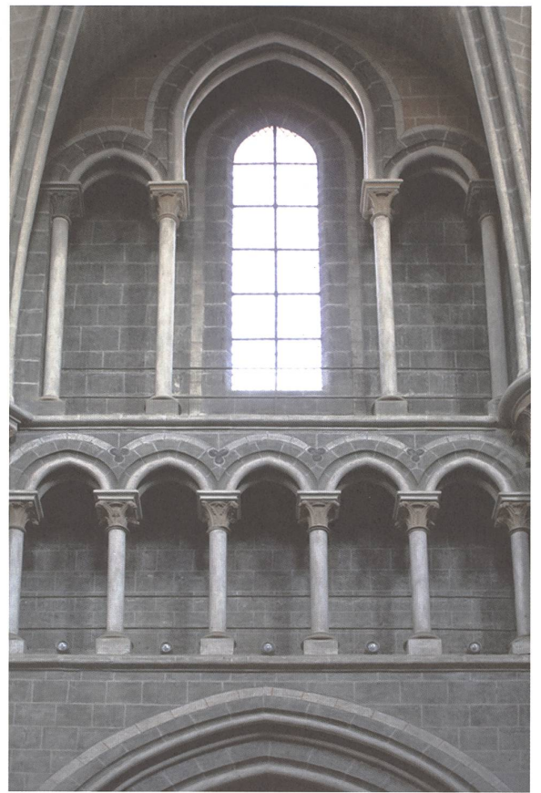
fig. 1 Nef, triforium et fenêtre-haute. Photographie : Dave Lüthi
