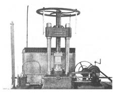
Druckpresse bis 120 t, in Verwendung durch die Festigkeits-Anstalt, aus: Tetmajer 1893.<sup>6</sup>
