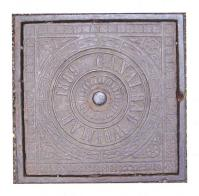
fig. e Weimar, Schachtabdeckung von Canalbau Weimar 1889, Fotografie: H. R. Stühlinger
