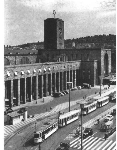
Paul Bonatz, Fritz E. Scholer, Hauptbahnhof , Stuttgart, 1914-1928, Foto.
