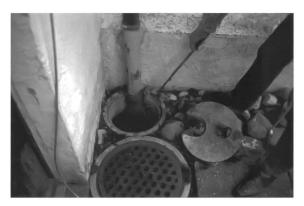
Schäden durch mangelhafte Sockelentwässerung, Zell, Reformierte Kirche
