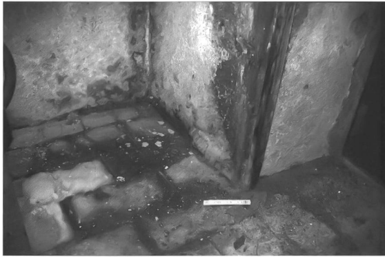
Schäden, hervorgerufen durch in angrenzende Tonplatten und Mörtel eingedrungene Salze aus dem Portlandzement, Zürich, Schulhaus Scherr
