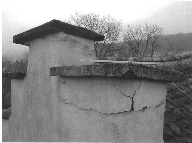
Frostschäden infolge ins Mauerwerk eindringenden Wassers, Untere Mühle, Otelfingen, Fotografie: Andreas Küng
