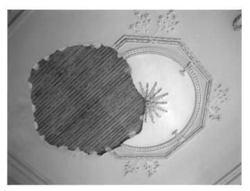
In einer früheren Sanierug überklebte Risse in der Stuckdeche führten zu einem Haftungsverlust. Trogen, Rathaus
