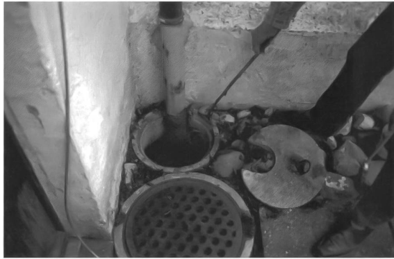
Schäden durch mangelhafte Sockelentwässerung, Zell, Reformierte Kirche
