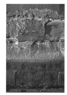
Zementmörtelflicke beschleunigen die Zerstörung des porösen Sandsteins, Zürich, Sihlquai 332
